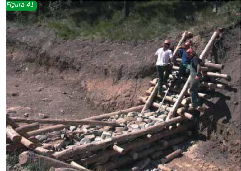
Figg.40-41-42-43: fasi costruttive di una briglia con ali molto pronunciate
