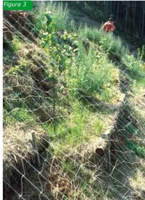
5. Disposizione di talee e/o piantine radicate di specie arbustive e/o arboree dotate di elevata capacità di vegetare e in grado di emettere radici dal fusto interrato (minimo 20 talee e/o 5 piantine al metro lineare). Nel caso delle palificate a pali orizzontali sovrapposti è possibile inserire la vegetazione tra un palo e l'altro, avendo cura di separare gli stessi con dei cunei in legname al momento della posa della paleria.
