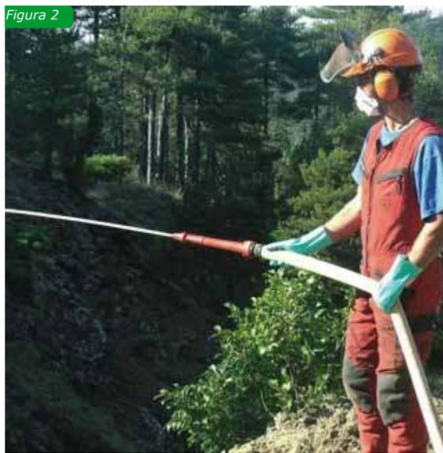
Fig. 1-2: inerbimento mediante idrosemina
