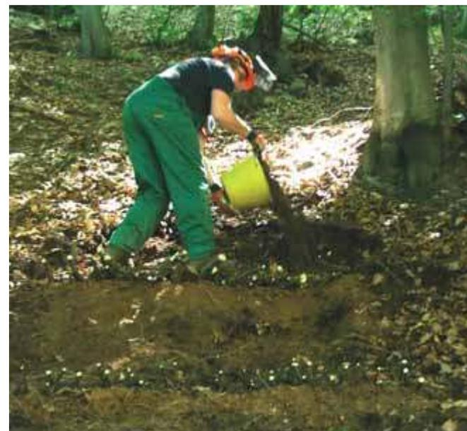
L'infissione di talee a chiodo (figg.20-21-22) è una tecnica di messa a dimora per la rivegetazione di versanti, scarpate e sponde, che prevede l'impiego di talee di grosse dimensioni, lunghe in genere da 50 cm a 1 m, da posare a seguito dell'eventuale rimodellamento del terreno come da progetto, con la seguente successione operativa:
