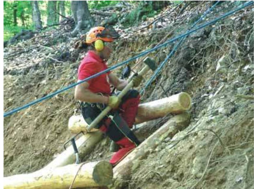
*Fissaggio delle travi ai montanti mediante chiodatura*
