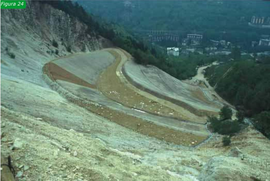
Figg.24-25: le reti in fibra naturale hanno ampiamente dimostrato la loro utilità nel costituire resistenze all'erosione e supporto alla rivegetazione di versanti, se opportunamente rimodellati
