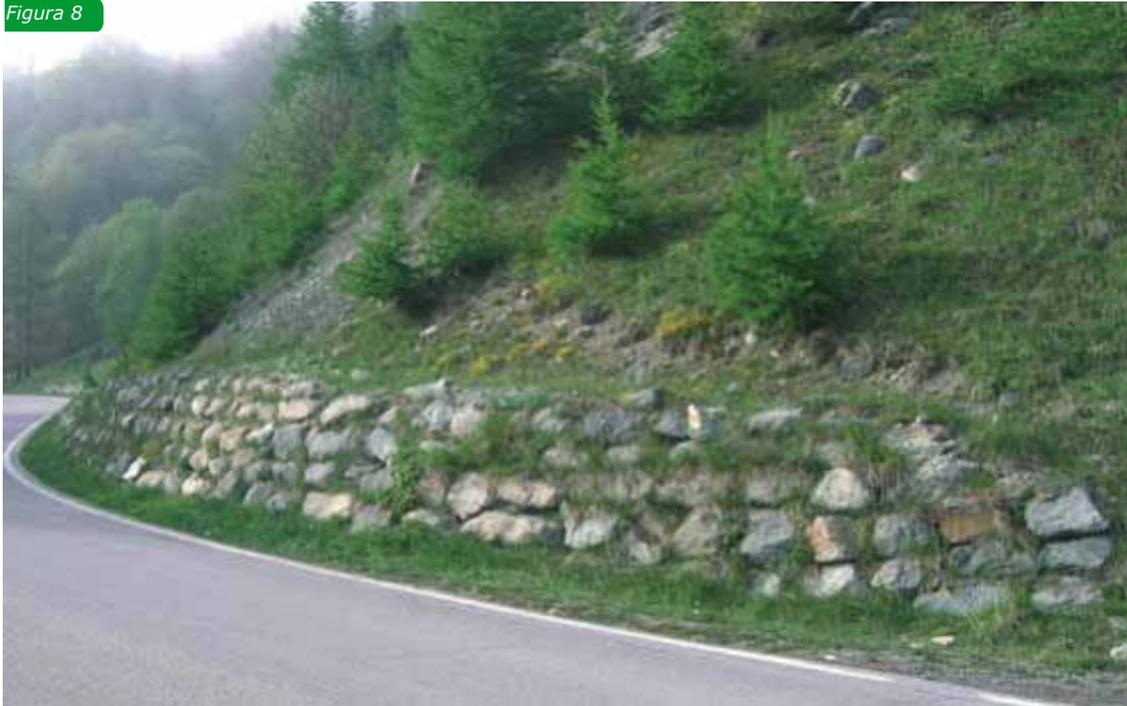
**Figg.8-9: scogliere rivegetate mediante inerbimento**
