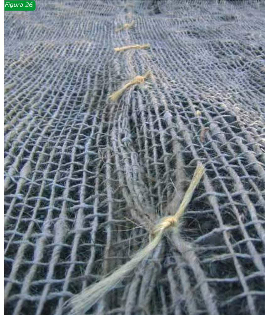
Fig.26: giunzione puntuale tra teli di rete in juta, mediante legature
