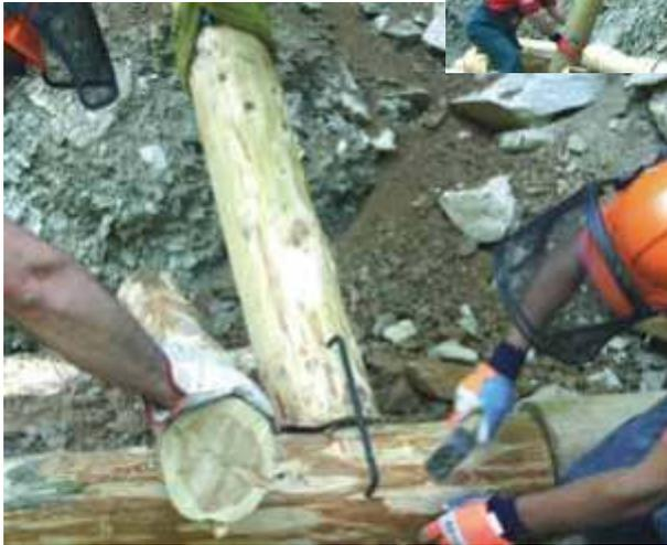
Collegamento del montante al corrente intermedio esterno della palificata di sostegno
