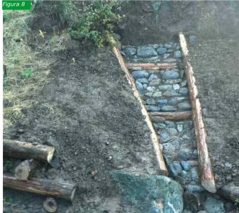
In altri casi, caratterizzati da pendenze e velocità di deflusso dell'acqua non elevate, possono essere realizzate canalette in terra, effettuando uno scavo avente sagoma trapezia, e disponendo opportunamente geosintetici antierosivi a protezione dello stesso.
