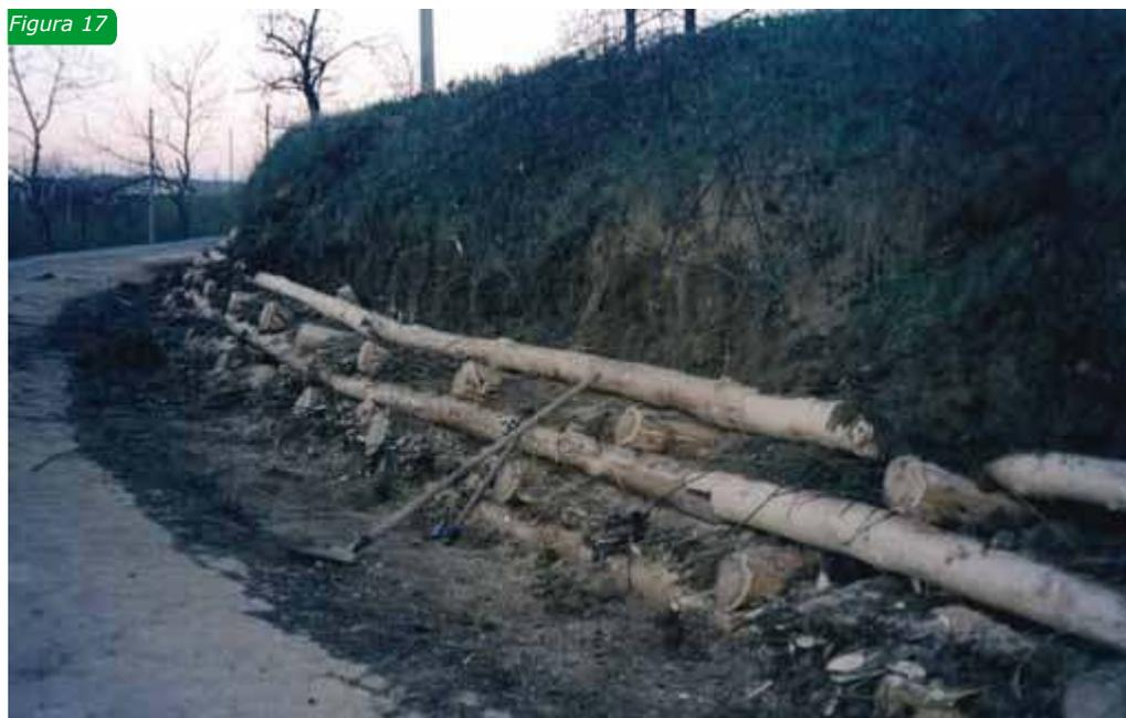
Le **palificate vive di sostegno a doppia parete** (figg.18-19) sono strutture **autoportanti** utilizzate di regola nella ricostruzione di versanti che sono stati interessati da fenomeni franosi.
