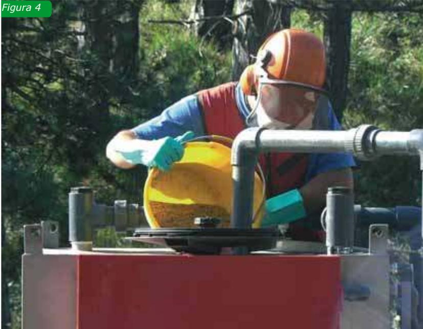
Fig.4: caricamento dell'idroseminatrice
