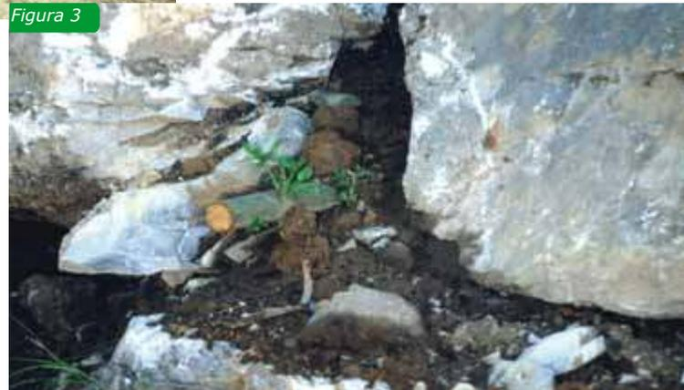
Le **scogliere intasate con terra e rivegetate** sono opere di sostegno ottimamente impiegate per il contenimento al piede di versanti e scarpate. Per la posa in opera vengono utilizzati escavatori, in grado di movimentare blocchi di elevata pezzatura media (da 0.3 m<sup>3</sup> a oltre 1 m<sup>3</sup>) e di forma irregolare.
