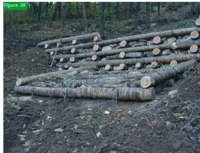
*Figg.37-38-39: costruzione di una briglia con platea di dissipazione in massi e legname, poste a valle del salto*
