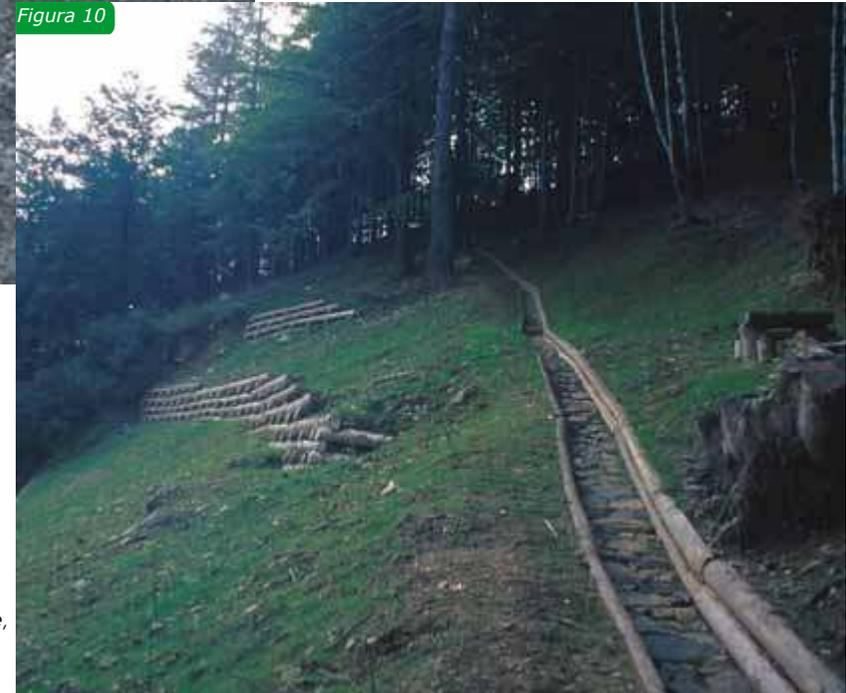
Fig.10: canalizzazione di acque realizzata con pali di legno e pietrame. Viene utilizzata per intercettare le acque che, da monte, interesserebbero un'area in frana
