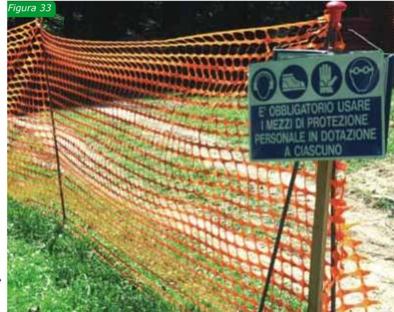
Fig.33: il cantiere deve essere perimetrato con recinzione idonea. Chi è autorizzato ad accedere deve comunque essere munito dei dispositivi di protezione individuale (DPI)
