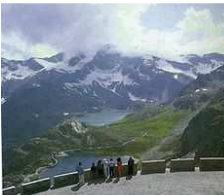
I laghi artificiali Agnel e Serrù visti dal colle del Nivolet
