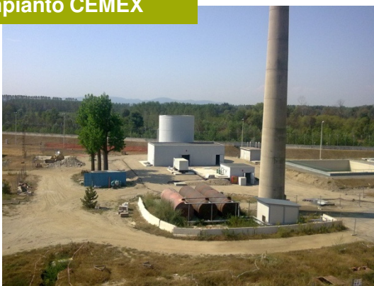
Area per la costruzione dell'impianto CEMEX
