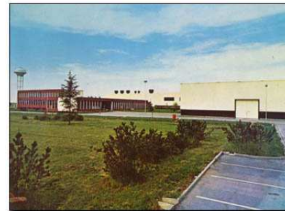
Impianto di Bosco Marengo
