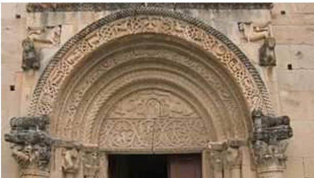
Lunetta sopra il portale della chiesa
