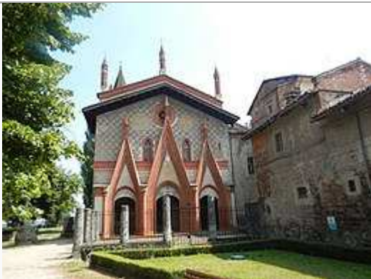
Facciata della chiesa
