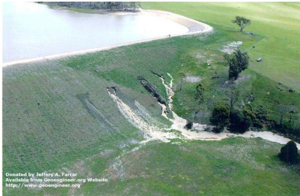
Figura 1. Meccanismo di crisi della diga Tunbridge, Tasmania, Australia (geoengineer.org Website)
