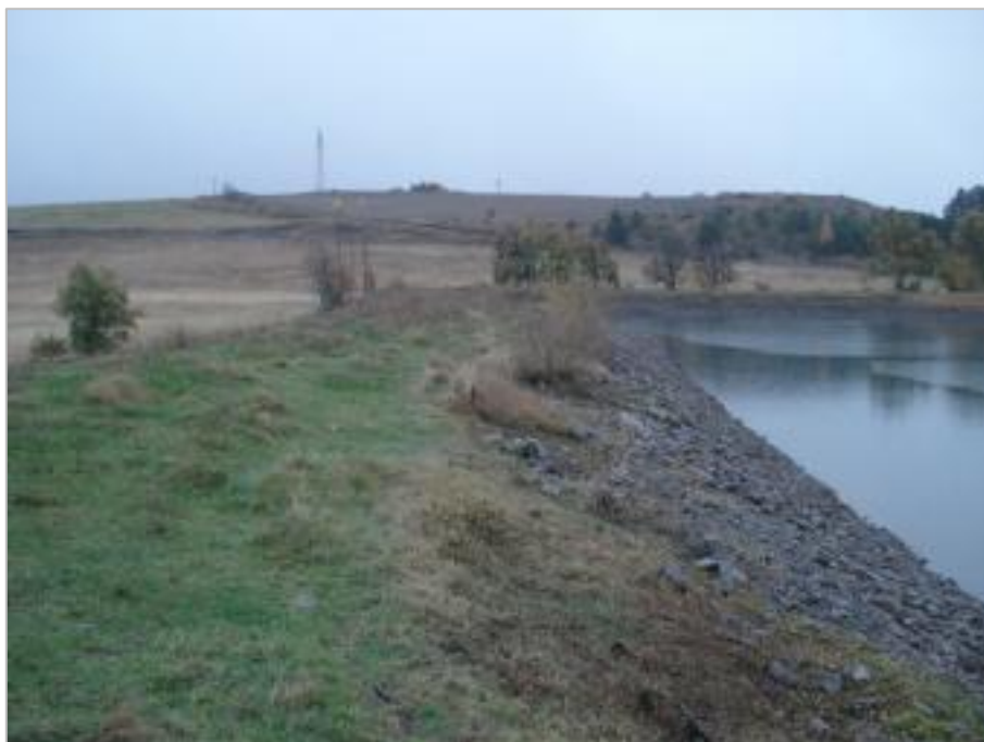
Figure 35. Vue de la retenue de P.. P.. depuis la crête (France – 05) - (photo : Mériaux P., 2014)
