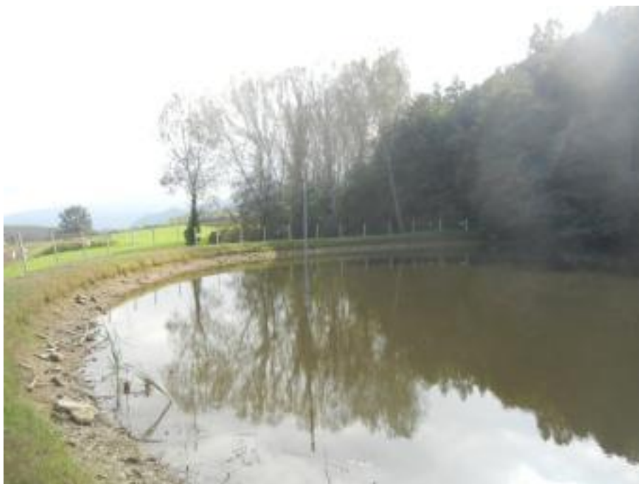
Figure 22. Vue depuis la crête du barrage d'O... (Italie) - (photos : Bambara G., 2014)
