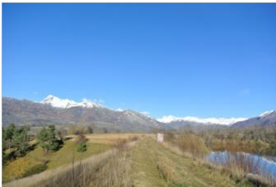
Figure 43. Vue du barrage des V... depuis la crête (France – 05) – (photo : Bambara G., 2014)
