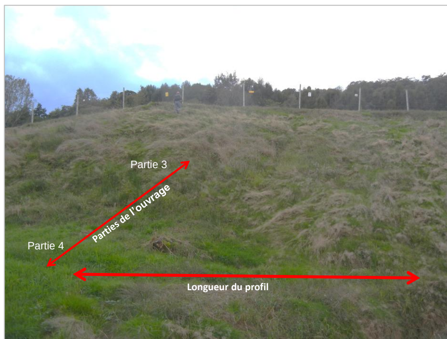
Figure 23. Profil choisi par le groupe d'experts pour l'évaluation de la performance du barrage d'O...vis-à-vis du mécanisme d'érosion interne. - (photos : Bambara G., 2014)
