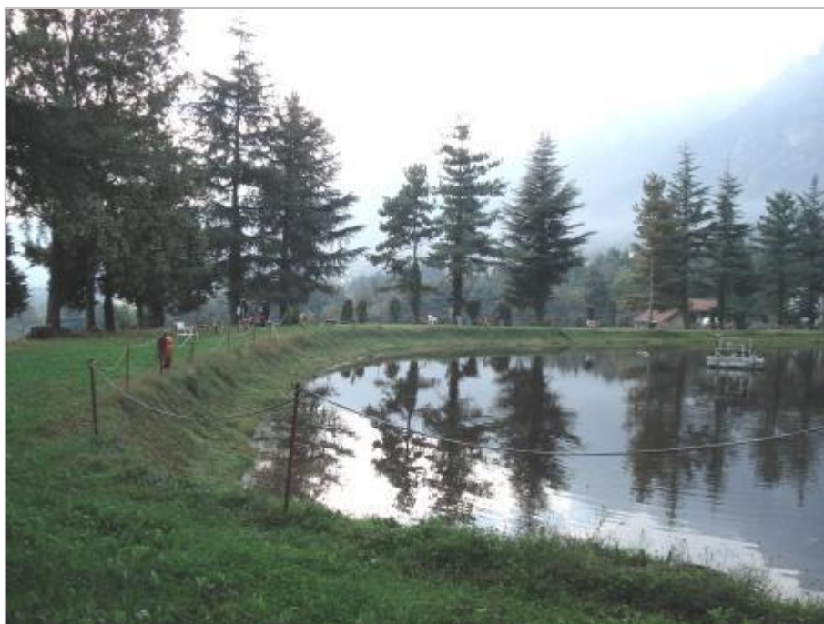
Figure 16. Répartition homogène des arbres sur le couronnement aval du barrage de Grengia (Italie) - (photo : Mériaux P., 2014)
