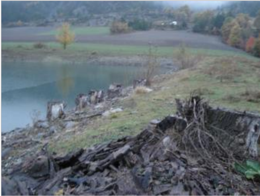
Figure 36. Souches en décomposition sur le couronnement amont et sur la crête de la retenue de P..P.. (France – 05) - (photo : Mériaux P., 2014)
