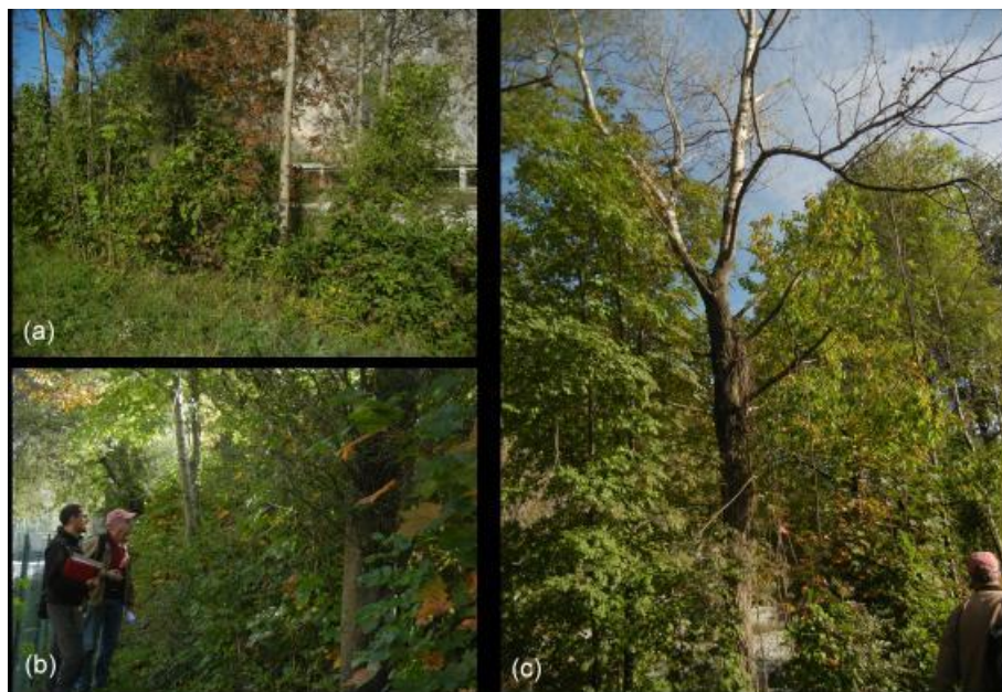
Figure 27. Profil choisi par le groupe d'experts pour l'évaluation de la performance du barrage vis-à-vis du mécanisme d'érosion (a : profil vu depuis la crête ; b : profil vu depuis le pied aval ; c : arbre mort sur le profil analysé) – (photos : Bambara G., 2014)
