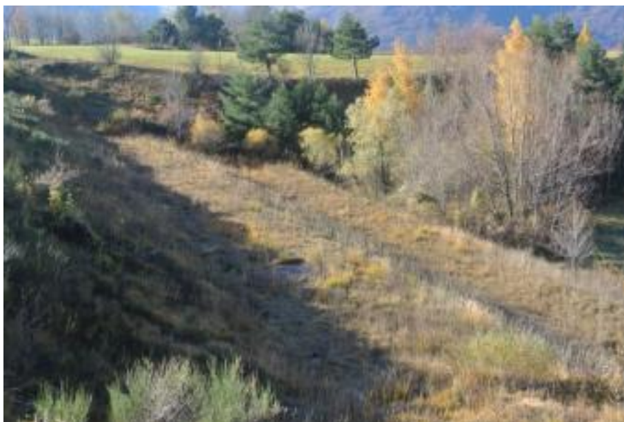
Figure 40. Vue du talus aval et de la végétation arborescente en rive gauche du barrage des B... (France - 05) – (photo : Bambara G., 2014)
