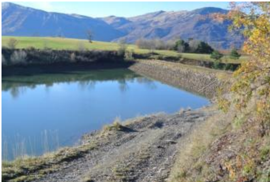
Figure 39. Vue du barrage des B... depuis l'amont (France – 05) – (photo : Bambara G., 2014)
