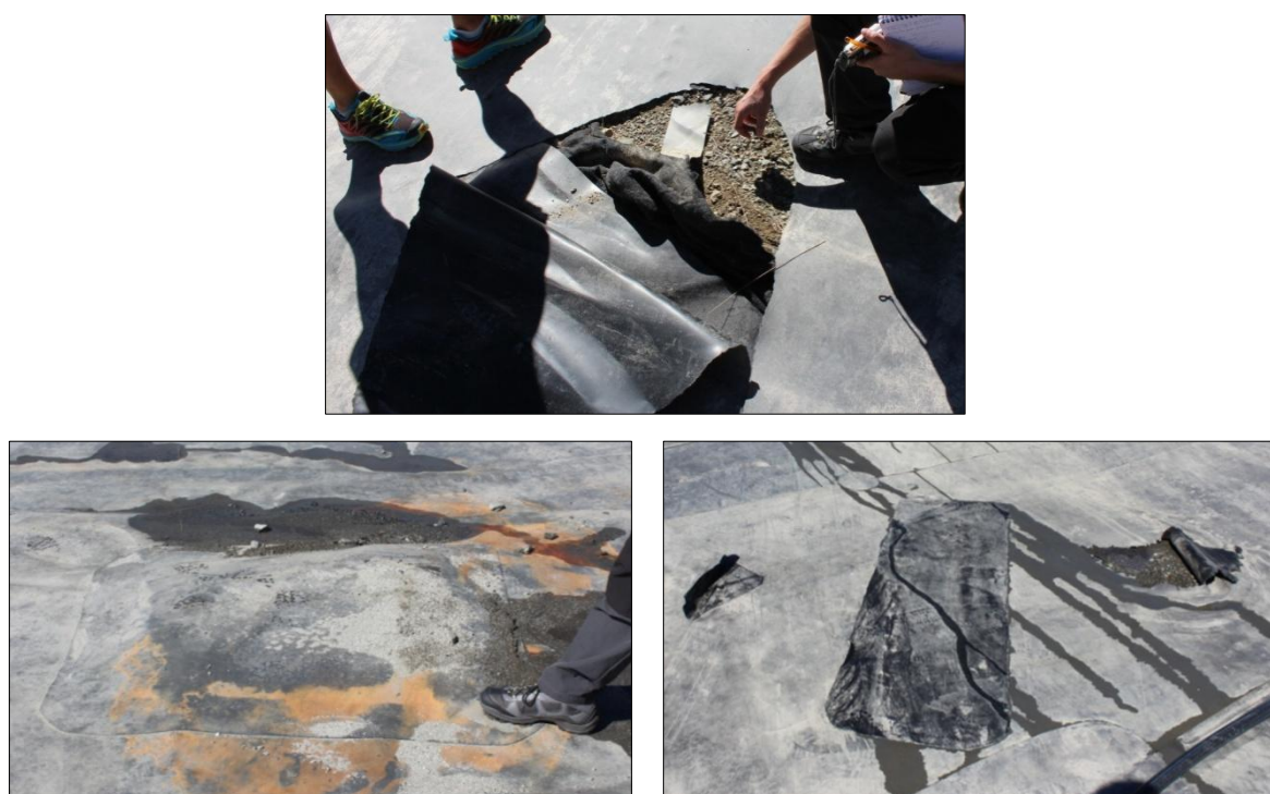
Figure 10 – Exemples de déchirures récentes et anciennes
