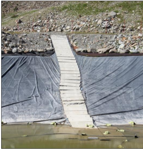
Figure 12 – Mise en tension de la géomembrane et dégradation de la rampe d'accès suite au glissement de cette dernière en fond de retenue
