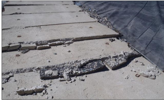
Figure 12 – Mise en tension de la géomembrane et dégradation de la rampe d'accès suite au glissement de cette dernière en fond de retenue
