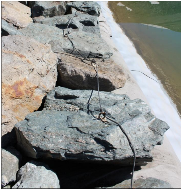
Figure 6 – Enrochements métriques en bord de risberme reliés par câble
