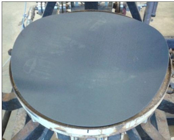
Figure 27 - Exemple de géomembrane mise en place au-dessus d'un géotextile de protection et d'une couche granulaire (voir Figure 25 et Figure 26)
