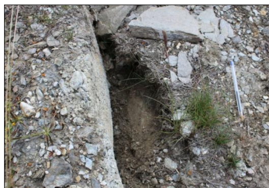
Figure 17 – Mise à nu du béton de la tranchée d'ancrage
