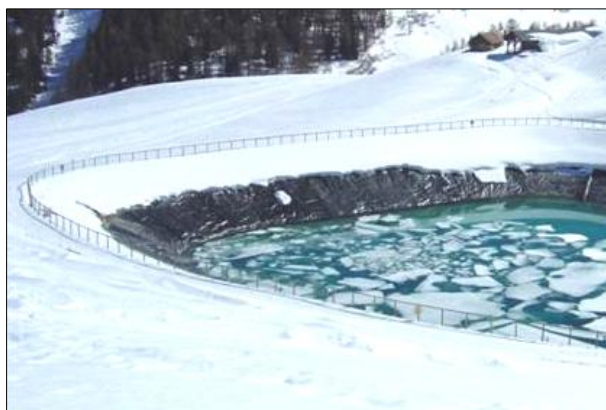
Figure 21 - Vue générale d'une retenue d'altitude étanchée par une géomembrane
