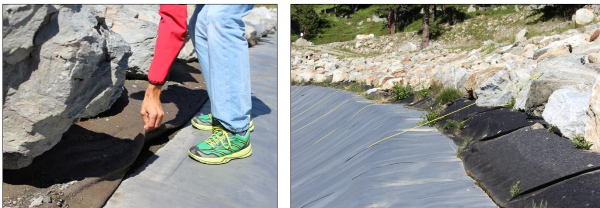
Figure 5 – Photos illustrant les “chaussettes” de géotextile mises en place sur les retenues Valdôtaines
