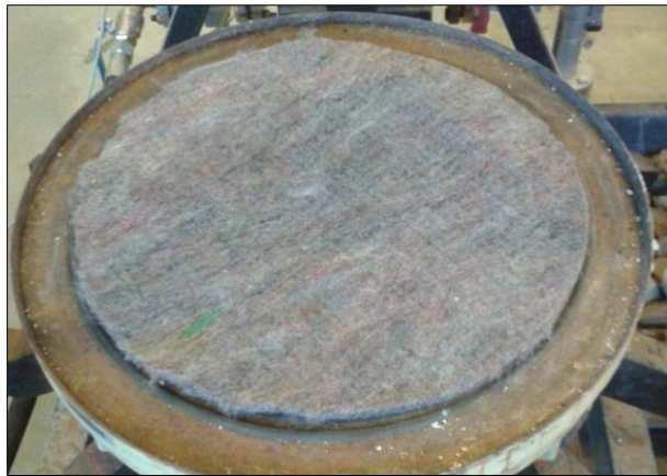
Figure 26 - Exemple de géotextile de protection (anti-poinçonnant) mis en place au-dessus d'une couche granulaire (voir Figure 25)
