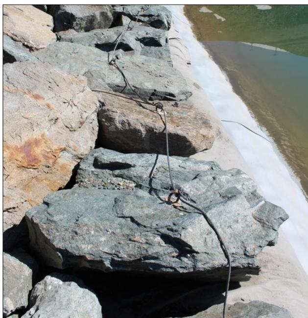
Figure 28 – Enrochements métriques en bord de risberme reliés par câble
