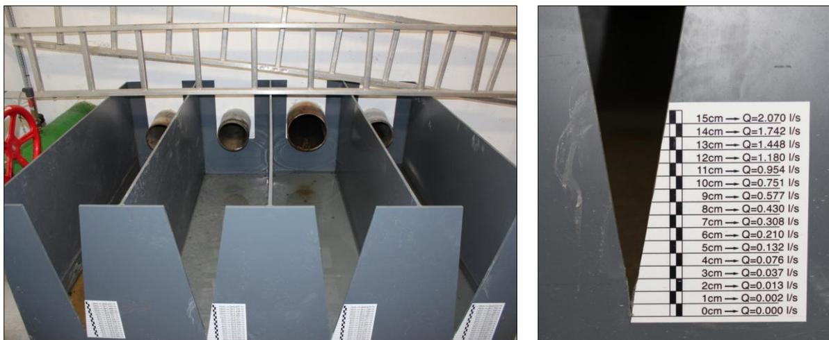
Figure 48 – 4 zones de drainage d'une retenue, accessibles depuis le local technique en aval de la retenue et dont les débits sont mesurés à l'aide d'une plaque déversante en V
