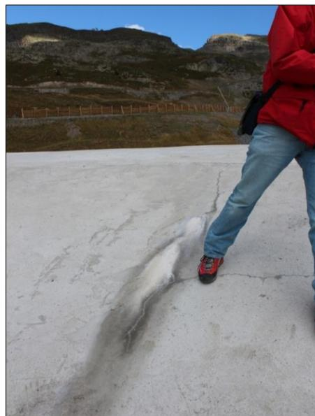
Figure 40 – Traces de circulation d’eau sur un évacuateur de crue
