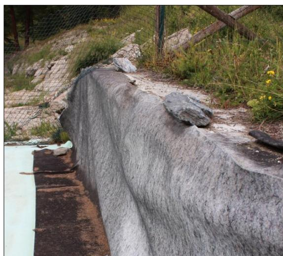
Figure 31 – Exemples de raccordement du DEG à des évacuateurs de crue en Italie
