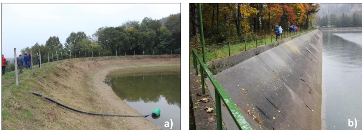
Figure 13 – Retenue en remblai étanche (a) dans la masse ;
