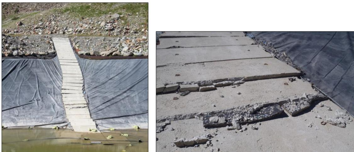
Figure 34 – Mise en tension de la géomembrane et dégradation de la rampe d'accès suite au glissement de cette dernière en fond de retenue
