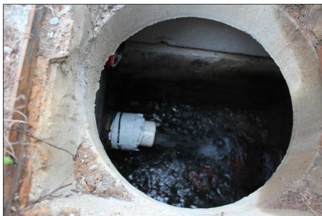
Figure 46 – Difficulté d'accès au débit de drainage sur une retenue
