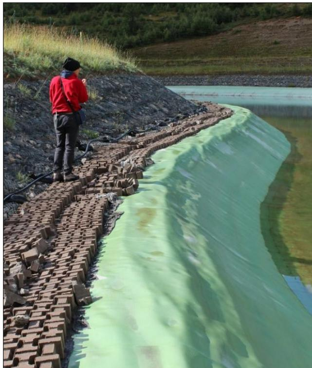
Figure 37 – Irrégularité de la structure support sous la géomembrane laissant supposer des instabilités superficielles locales
