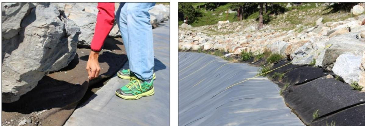
Figure 27 – Photos illustrant les "chaussettes" de géotextile mises en place sur les retenues Valdôtaines
