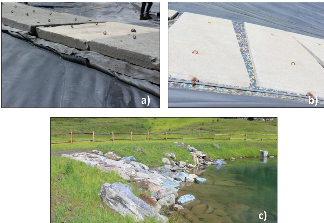
Figure 33 – Exemples de structures de protection de la géomembrane vis-à-vis des rampes d'accès
