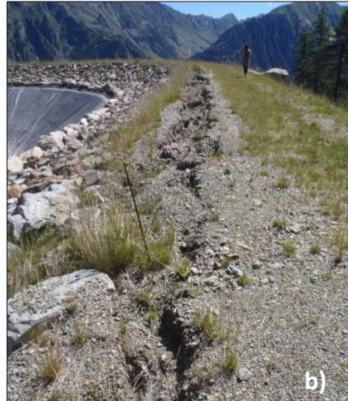
Figure 36 – Glissement du parement amont (a) avec rupture de la clé d'ancrage (b)
