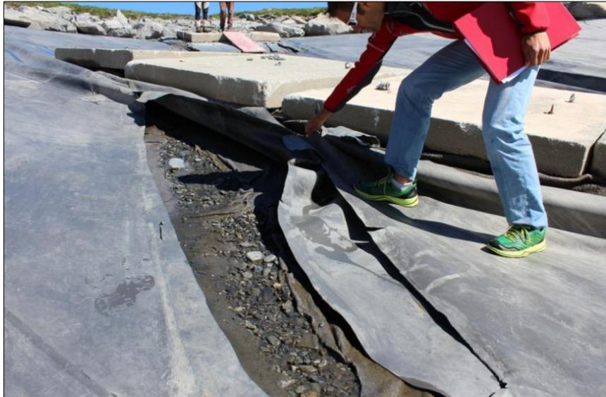
Figure 35 – Rupture des câbles et de la rampe :
