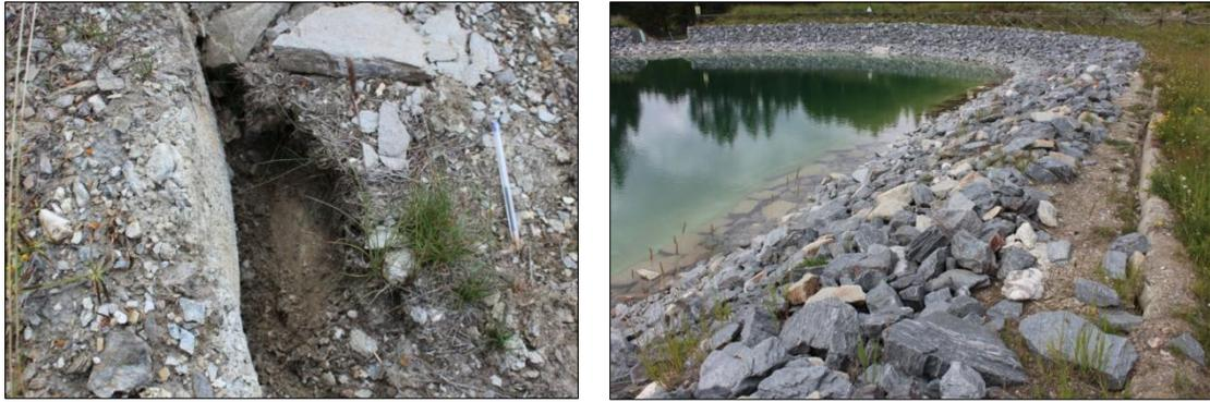
Figure 39 – Mise à nu du béton de la tranchée d’ancrage
