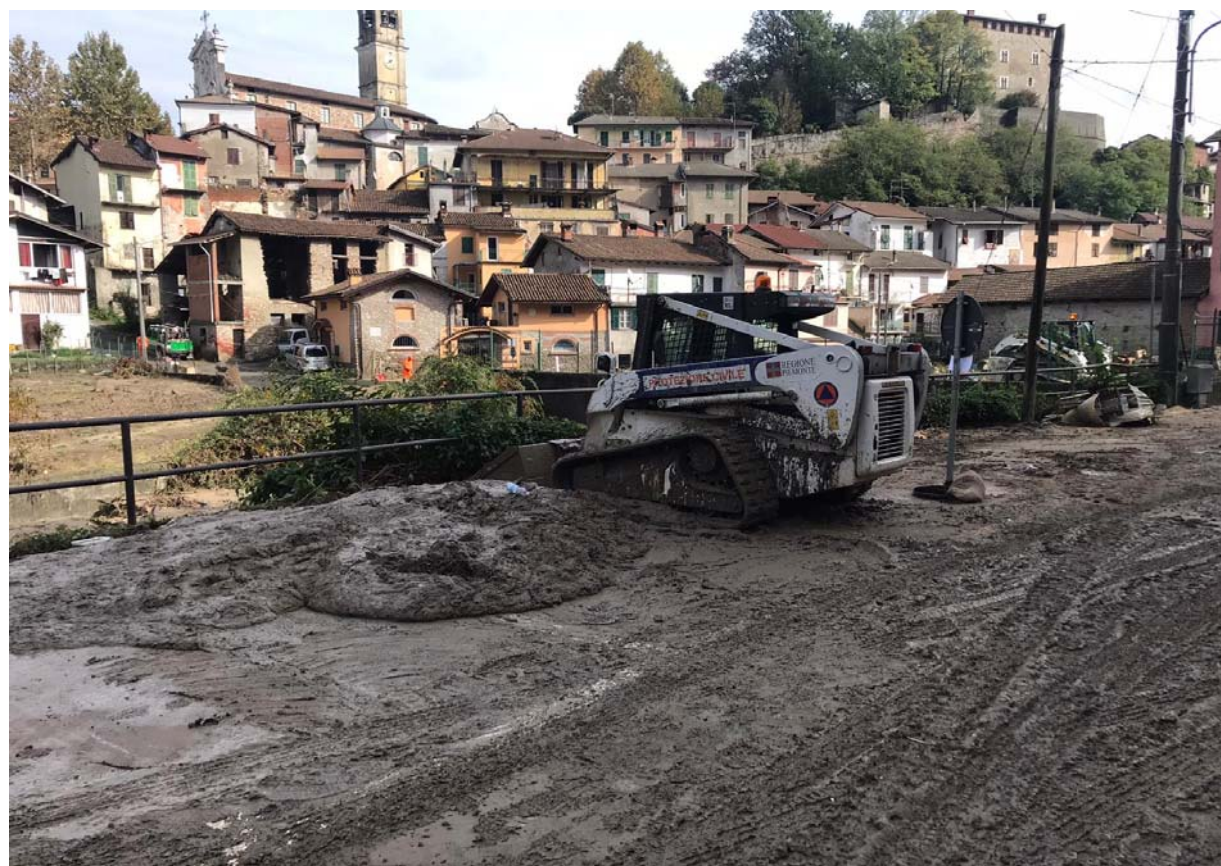
Attività di ripristino nel Comune di Castelletto d'Orba (AL)
