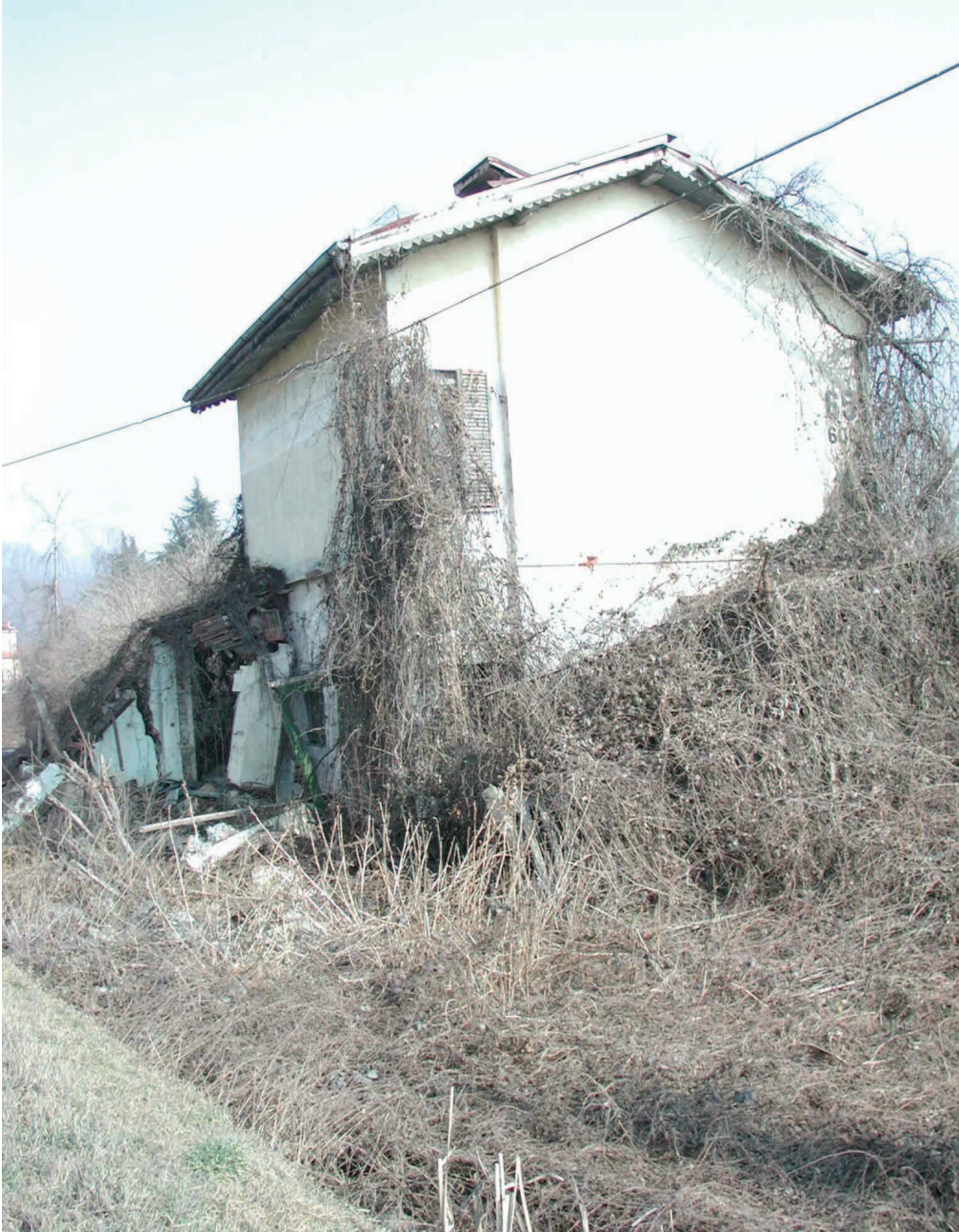
FIGURA 54: Casa Cantoniera al Km 65+600, Foglio 15, part. 314
