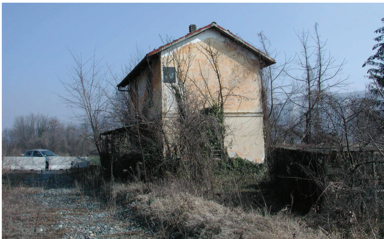
FIGURA 46: Casa Cantoniera al Km 67+288, Foglio 2, part. 44
