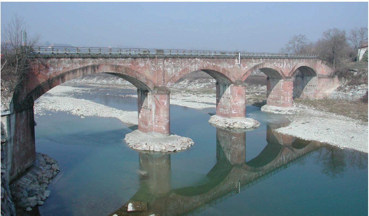
FIGURA 42: Ponte sul fiume Tanaro al km 69+214
