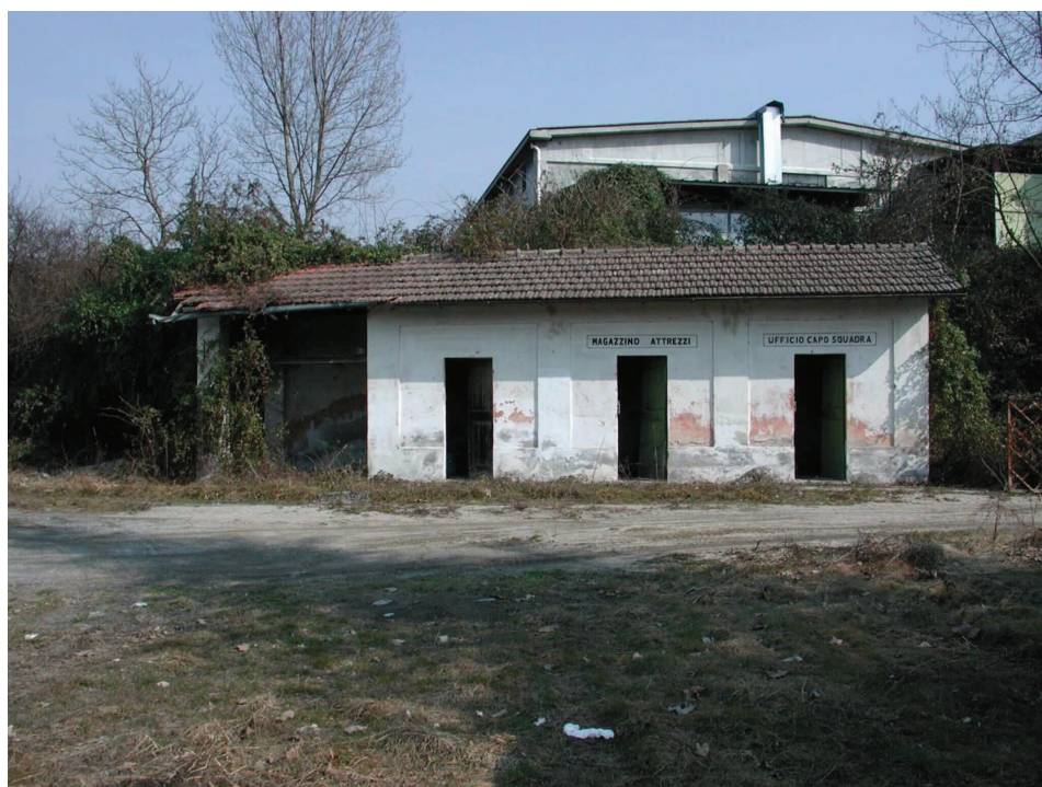
FIGURA 41: Fabbricato di stazione adibito a deposito
