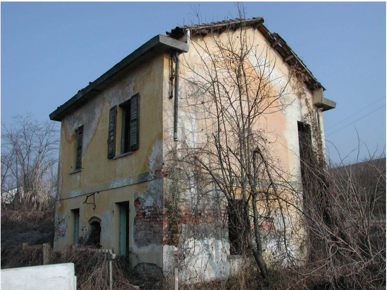
FIGURA 16: Ex tracciato ferroviario
