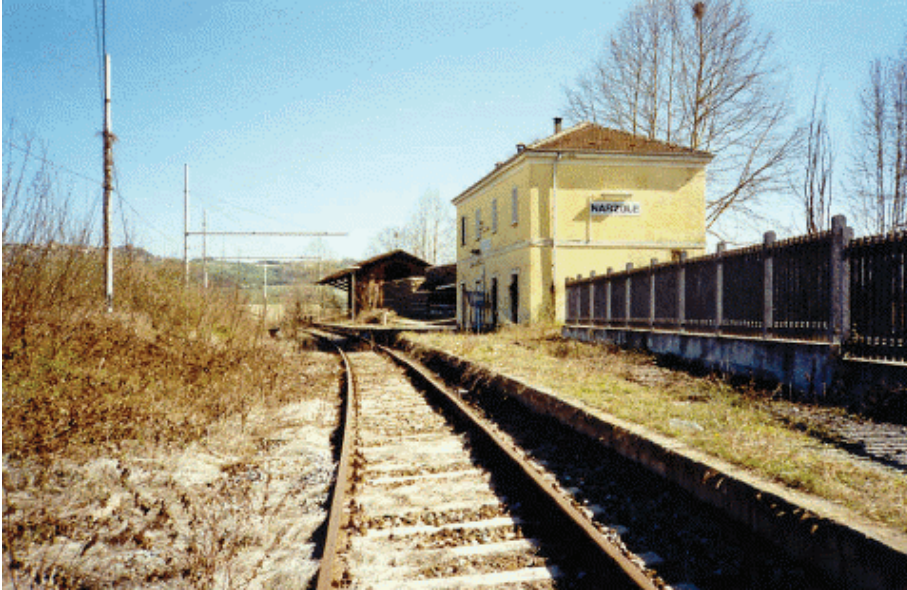
FIGURA 7: Fabbricato Viaggiatori e Magazzino Merci detto "piccola"
