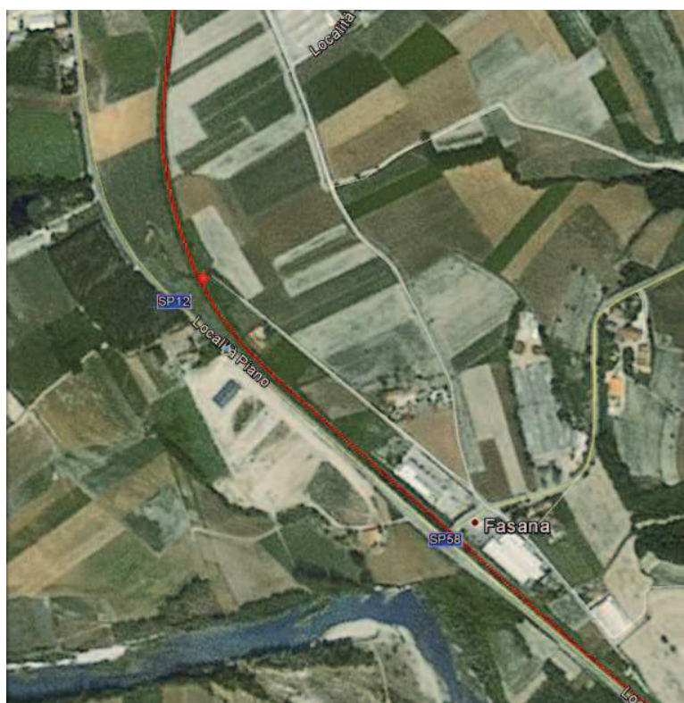
FIGURA 19: Ex tracciato ferroviario
