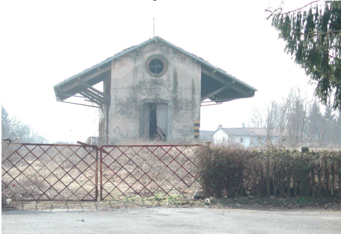
FIGURE 54-55: Magazzino Merci al Km 10+073
