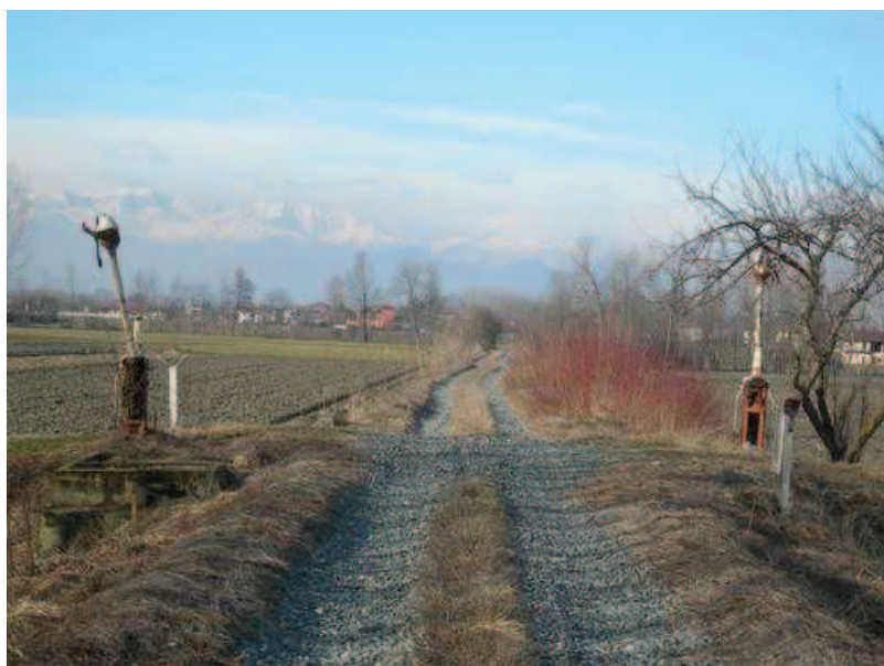
FIGURA 56-57: ■ Casa Cantoniera al Km 11+578 ➔ Sedime ferroviario
