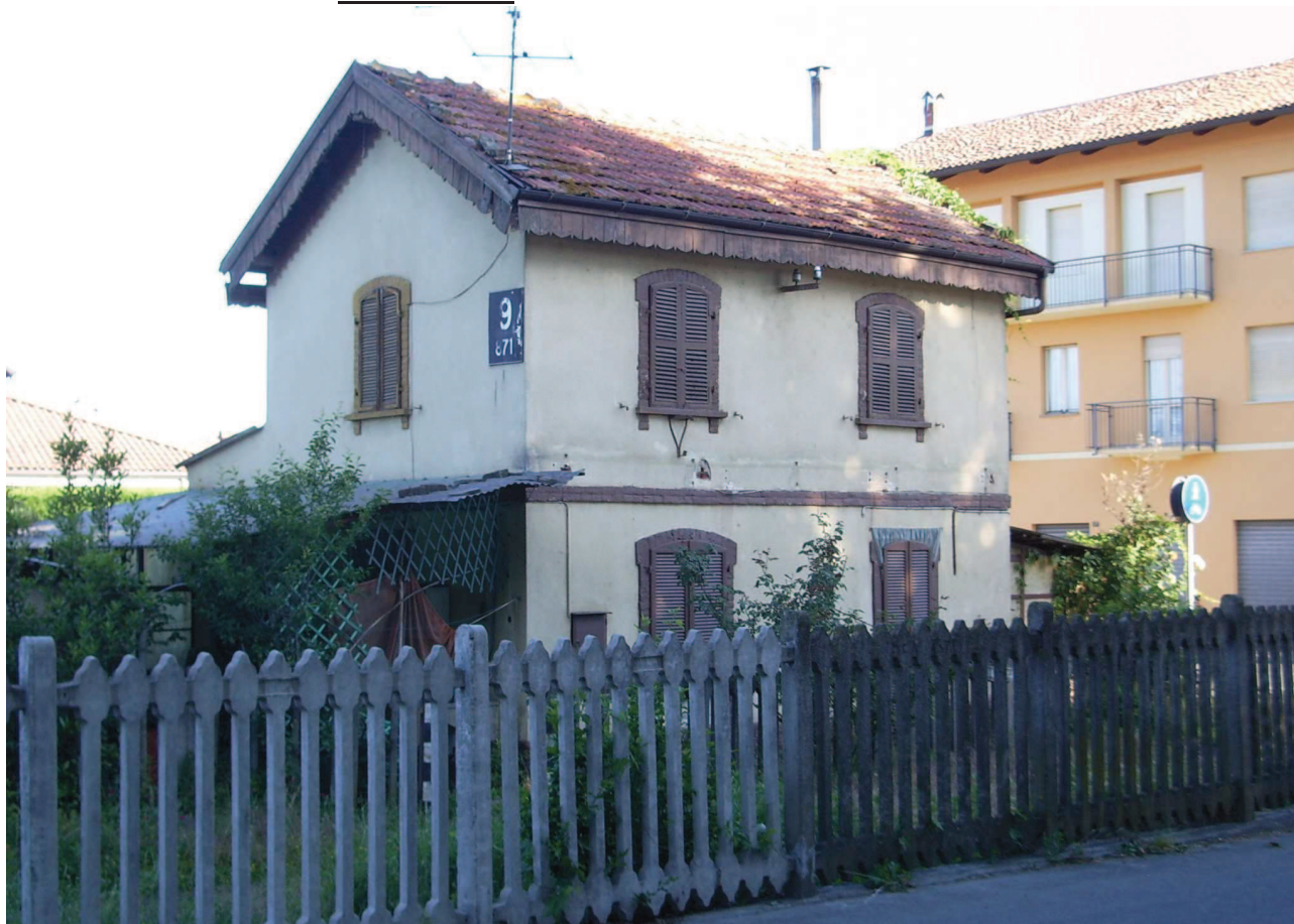
FIGURA 44 : Casa Cantoniera al Km 9+871
