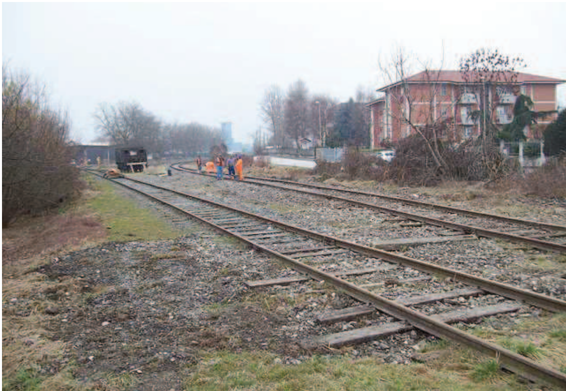
FIGURA 98: A Moretta incrociamo i binari della ex ferrovia
