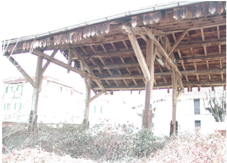
FIGURA 93 : Magazzino Merci al Km 19+349
