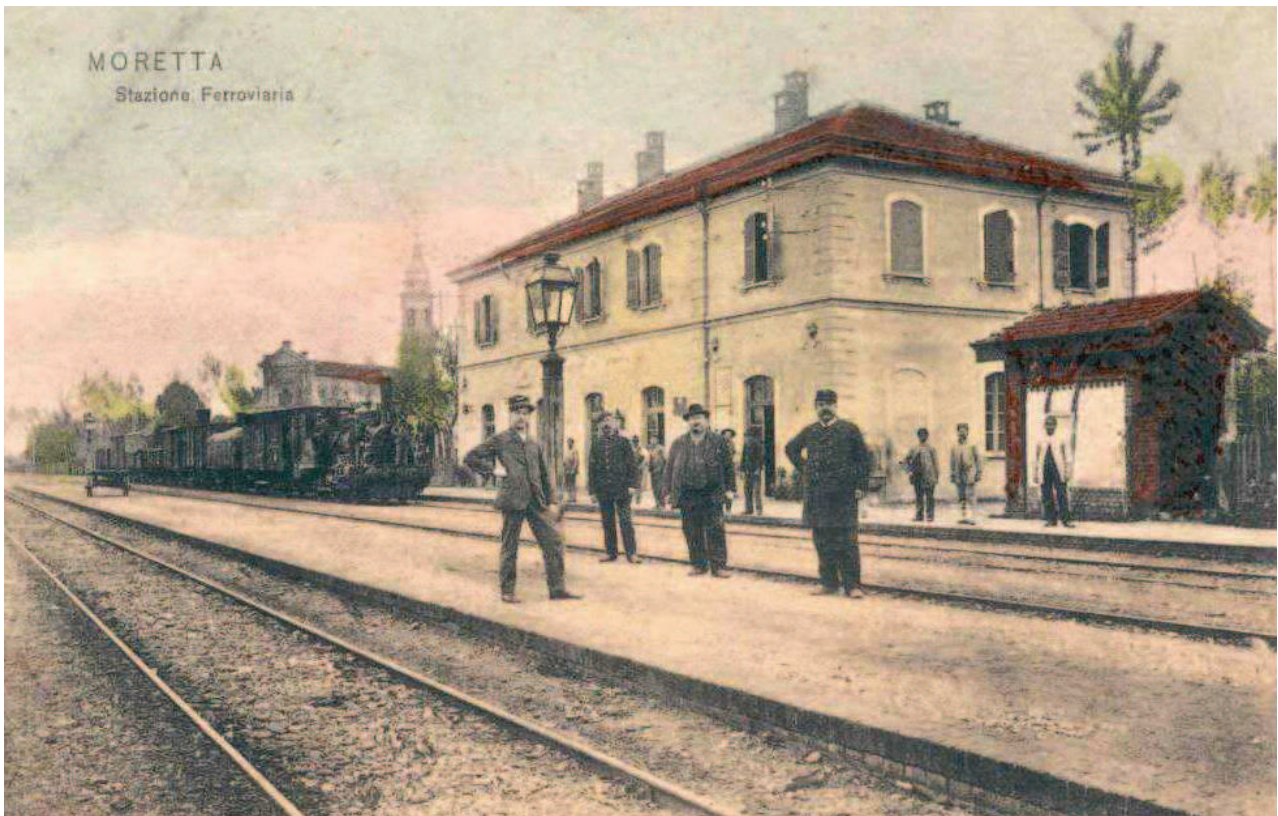
FIGURA 90: Immagine storica del Fabbricato Viaggiatori
