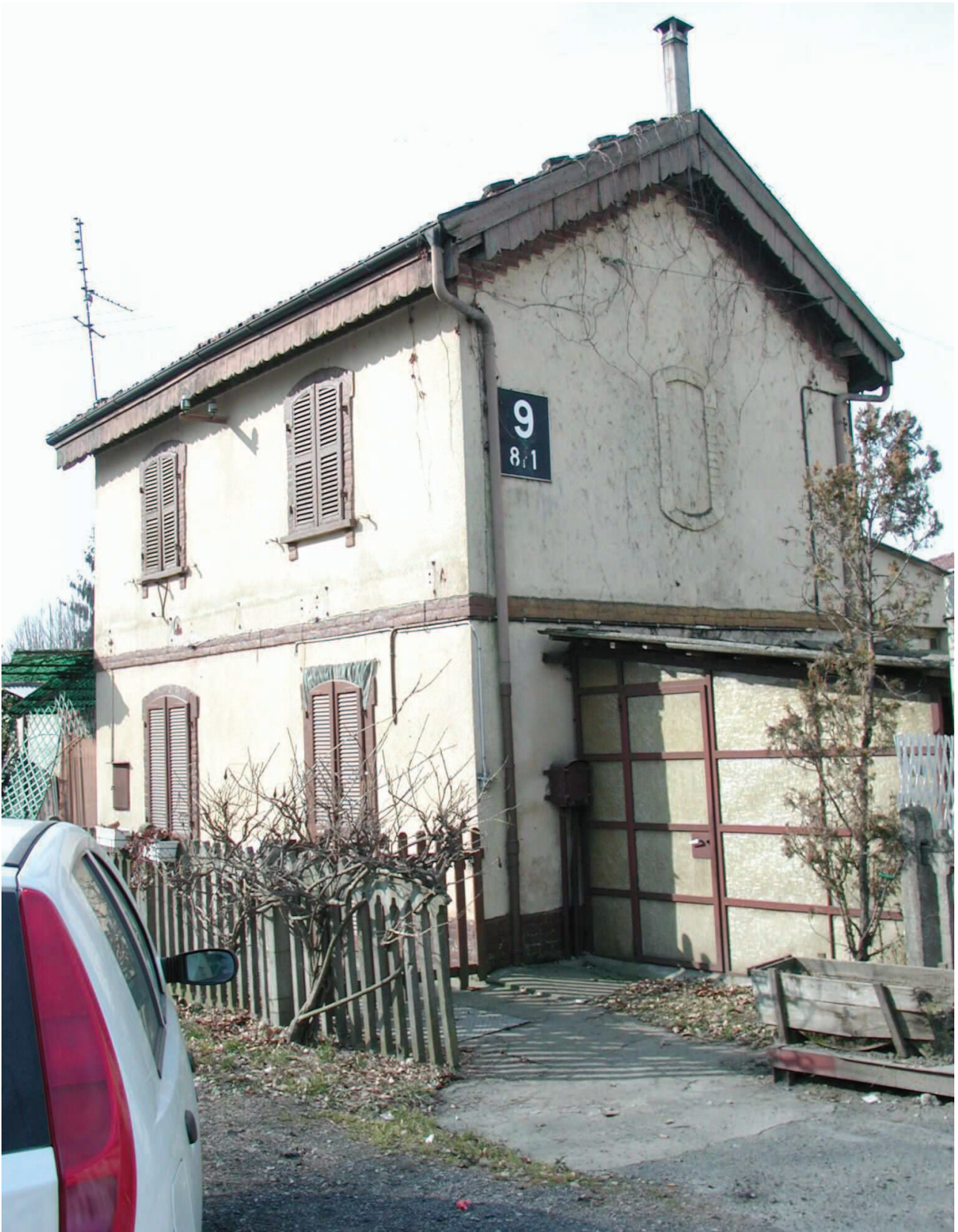
FIGURA 43 : Casa Cantoniera al Km 9+871
