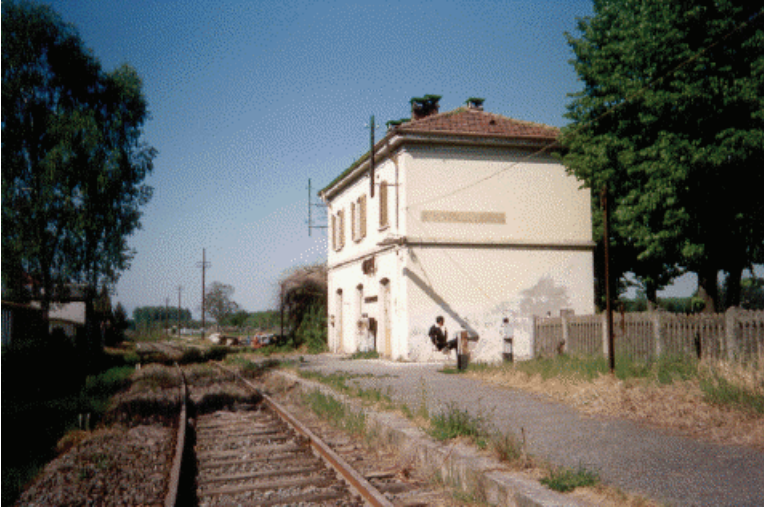
FIGURA 35-36: Fabbricato di stazione
