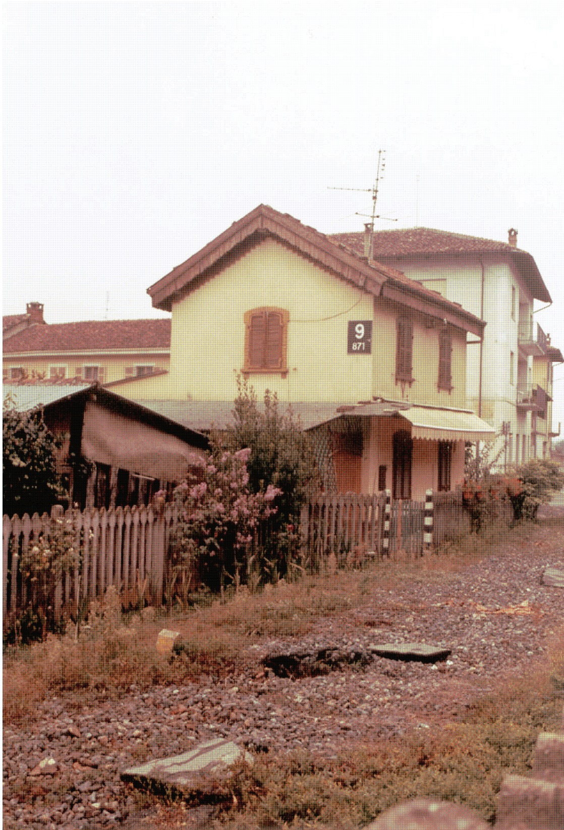
FIGURA 42 : Casa Cantoniera al Km 9+871
