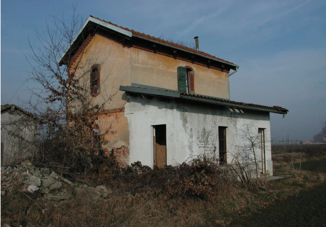
FIGURE 7-8: Casa Cantoniera al Km 2+795
