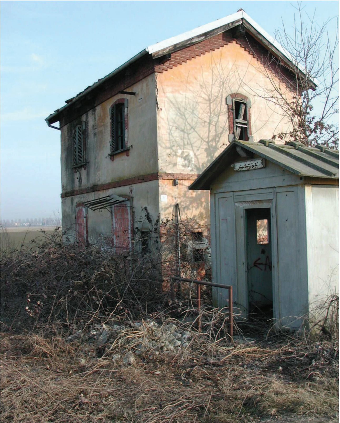
FIGURA 9: Casa Cantoniera al Km 2+795
