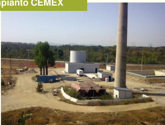
Area per la costruzione dell'impianto CEMEX
