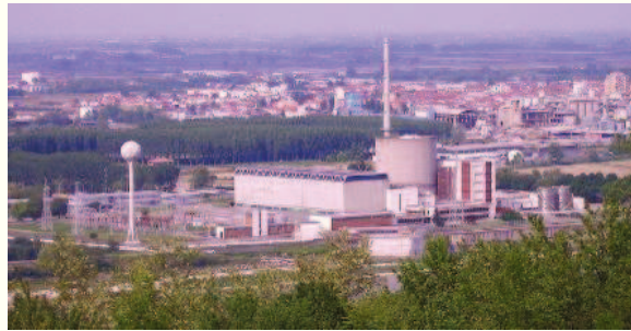
Centrale di Trino
