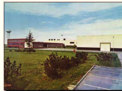
Impianto di Bosco Marengo
