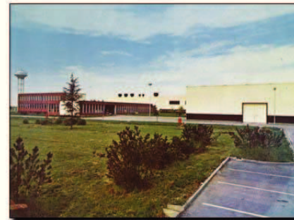
Impianto di Bosco Marengo
