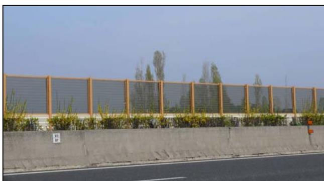
*Esempio di barriera con pannelli trasparenti con trattamento anticollisione dell'avifauna*
