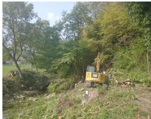
Manutenzione in alveo e lungo le sponde: escavatore e operai forestali in intervento di gestione della vegetazione riparia – Settore A1824B, Regione Piemonte
