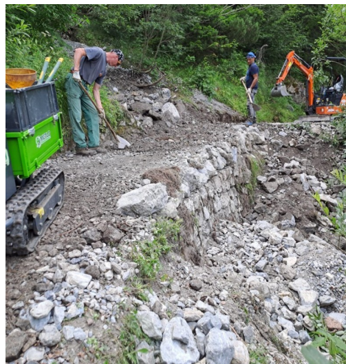
Ripristino di sentiero escursionistico: operai forestali al lavoro con mezzi meccanici – Settore A1824B, Regione Piemonte
