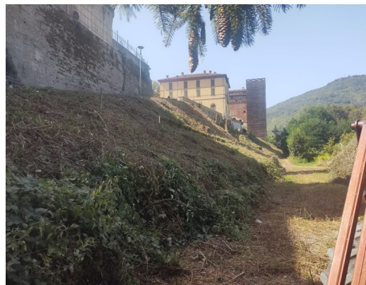
Manutenzione di versanti e cigli stradali: pulizia del ciglio stradale con trattore e operaio forestale – Settore A1824B, Regione Piemonte
