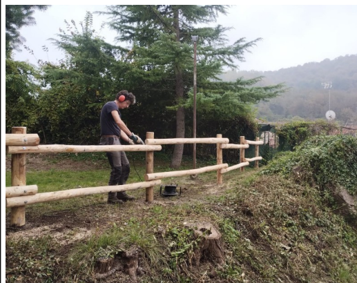
Manutenzione di parchi e aree attrezzate: installazione di staccionata in legno – Settore A1824B, Regione Piemonte
