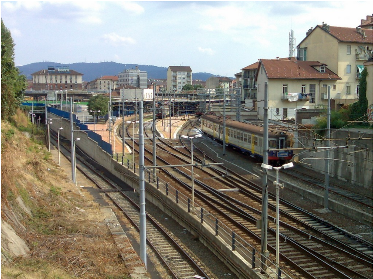
Panoramica della Stazione Dora
