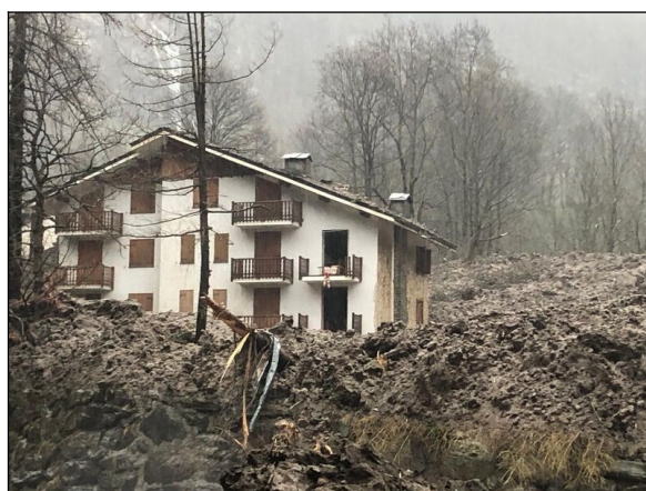
Fig. 1 Edificio investito e danneggiato dalla valanga del 16-17 aprile 2025
