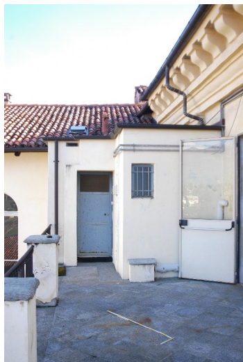
TERRAZZI ADIACENTE AL LOCALE OGGETTO DI LAVORO
