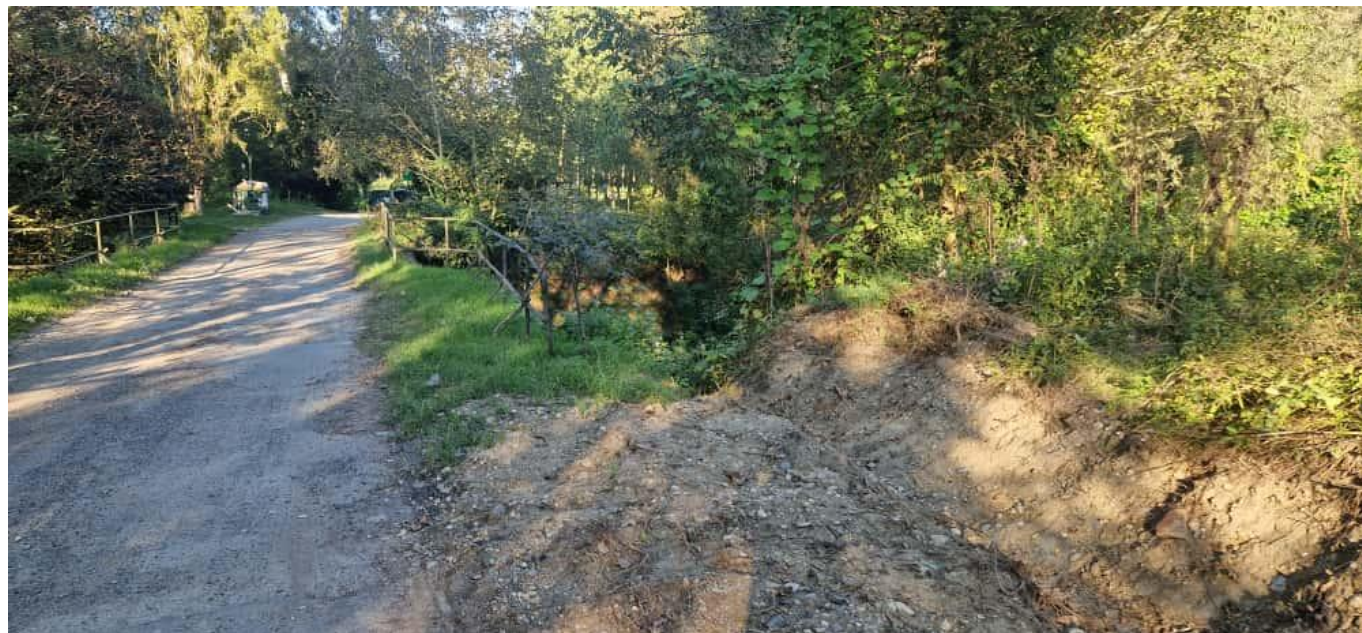
Immagine sponda destra a valle del ponte
