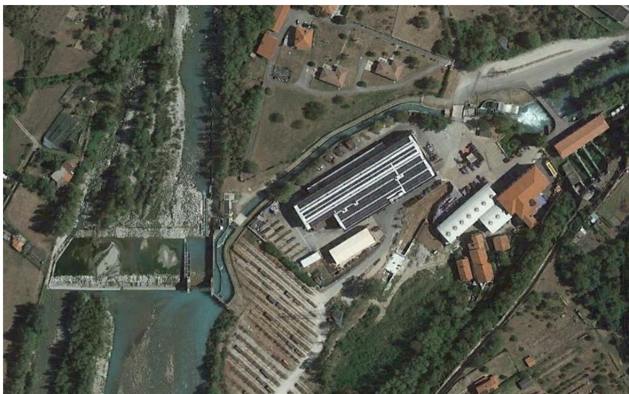
Figura 3-4: impianto Edison di Cuornè
