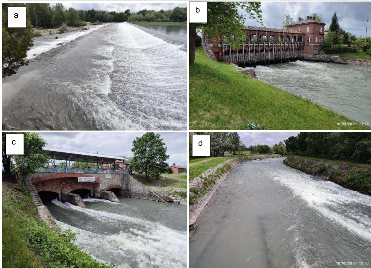
Figura 5-15: traversa in alveo (a), derivazione Canale Farini (b), presa (c) e canale scaricatore (d) e localizzazione (sopra)
