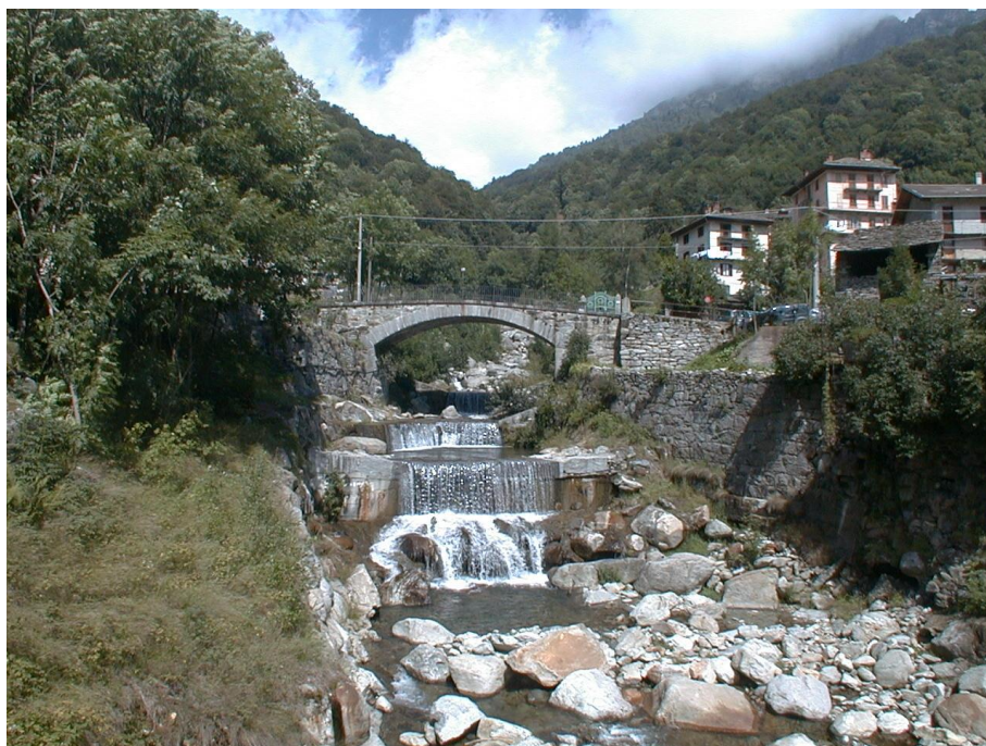
Foto 3 - Stesso tratto di torrente prima dell'evento alluvionale del 2020
