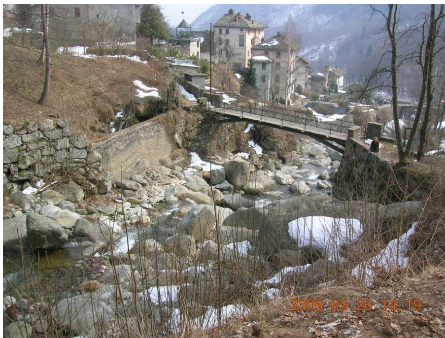
Foto 23 - Passerella pedonale (ponte del Valjer) distrutta nel 2020
