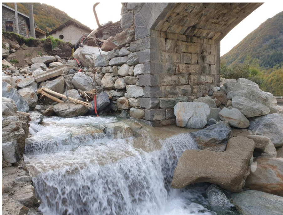
Foto 13 (9 ottobre 2020) Dettaglio della spalla sinistra del ponte di via Roma (prima dei lavori di somma urgenza)
