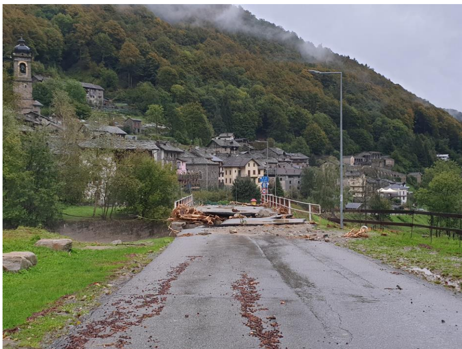
Foto 5 (mattina del 3 ottobre 2020) Danni alla strada provinciale e al piano viabile del ponte per effetto della divagazione della piena in sponda destra
