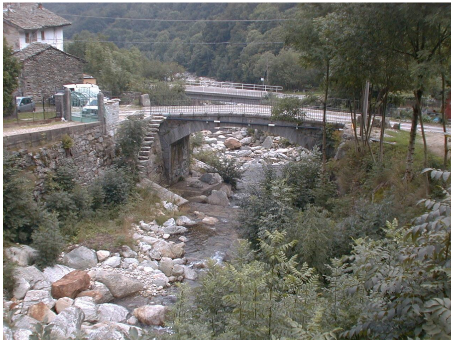
Foto 16 - Ponte di via Roma prima dell'evento alluvionale del 2020
