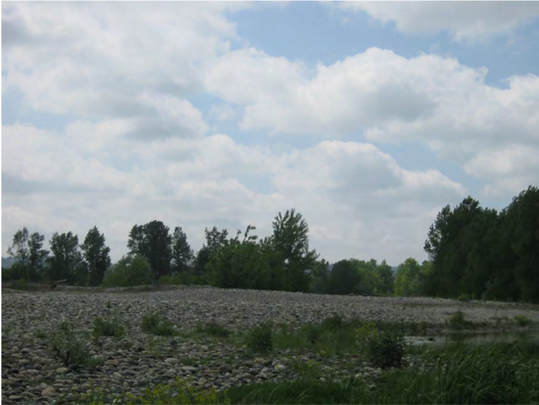
FOTO 27 – Vista del centro alveo del Fiume Po in corrispondenza dello sbocco canale Nord
