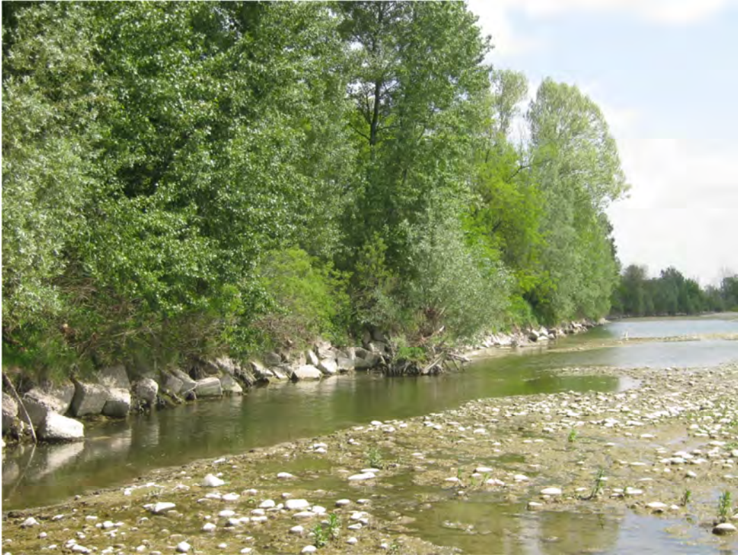
FOTO 25 – Vista dall'alveo della sponda sinistra Fiume Po dove presente l'opera di difesa in prismi in corrispondenza dello sbocco del canale Nord
