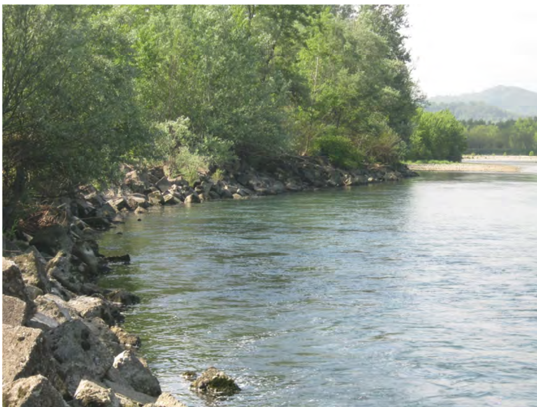
FOTO 20 – Vista verso valle del fiume Dora Baltea e dell’opera in prismi di calcestruzzo all’imbocco del canale Sud
