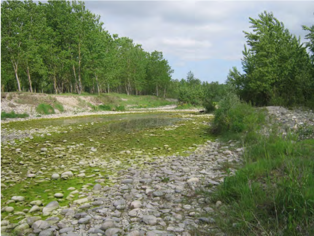
FOTO 1 – Vista da valle verso monte canale Sud
