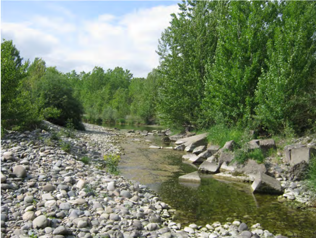
FOTO 15 – Vista lato valle dell’opera in prismi di calcestruzzo all’imbocco del canale Sud
