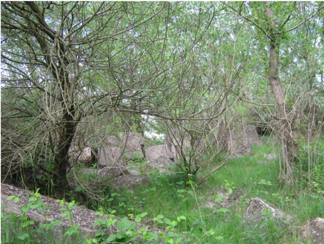
FOTO 22 – Vista dell'area dove previsto l'imbocco del canale Nord a tergo dell'opera in prismi esistente
