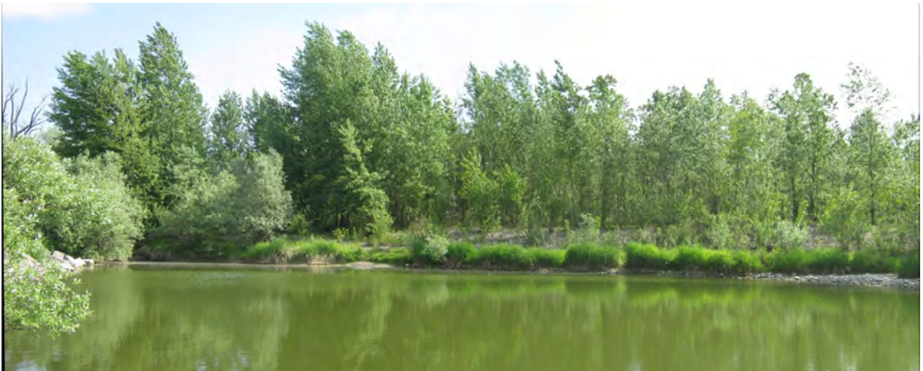
FOTO 16 – Vista a valle dell’opera in prismi di calcestruzzo all’imbocco del canale Sud
