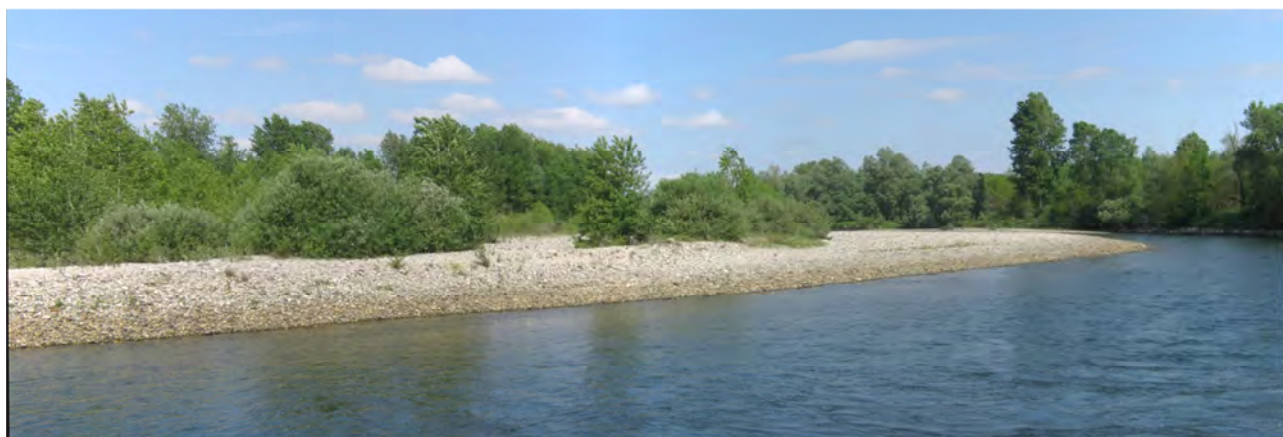
FOTO 18 – Vista sponda destra del fiume Dora Baltea in corrispondenza dell’imbocco dei canali
