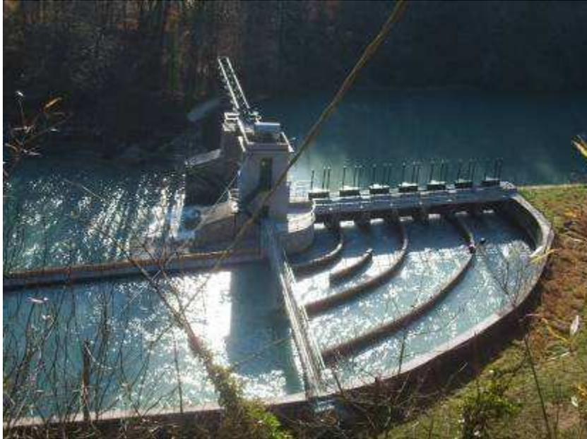
**Figura A3.5** Sezione di derivazione che può fungere da sezione di monte del modello: Sbarramento, opera di presa e canale di derivazione della centrale di Roccasparvera, Valle Stura di Demonte.
