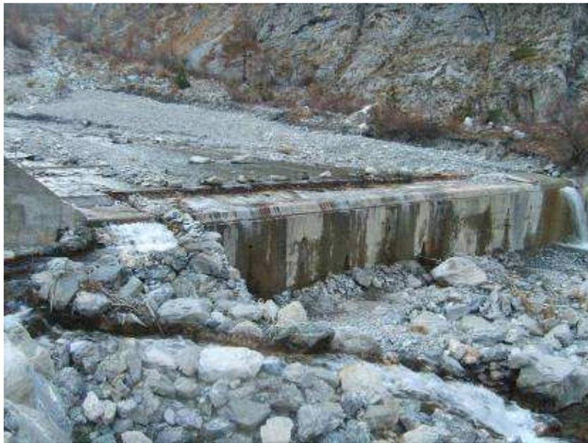
**Figura A3.4** Sezione di derivazione che può fungere da sezione di monte del modello: presa a trappola dell'impianto Cascate e Cataratte, Valle Stura di Demonte.
