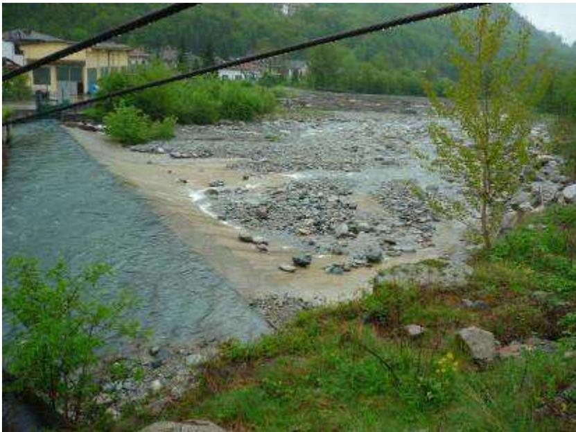
**Figura A3.6** Sezione di derivazione che può fungere da sezione di monte del modello: traversa di alimentazione della centrale di Castel del Bosco, Val Chisone.
