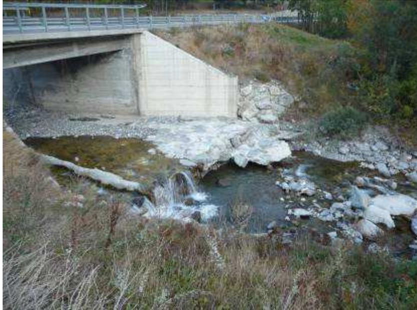
**Figura A3.12** Sezione non adatta alla chiusura a valle del modello: ponte senza pile in alveo, con fondazione continua a platea o in corrispondenza di un rivestimento inerosibile del fondo che presenta erosione immediatamente a valle della stessa.
