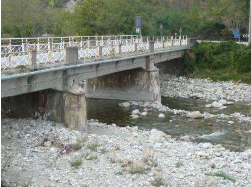
**Figura A3.14** Sezione non adatta alla chiusura a valle del modello: ponte con pile in alveo e privo di fondazione a platea continua.
