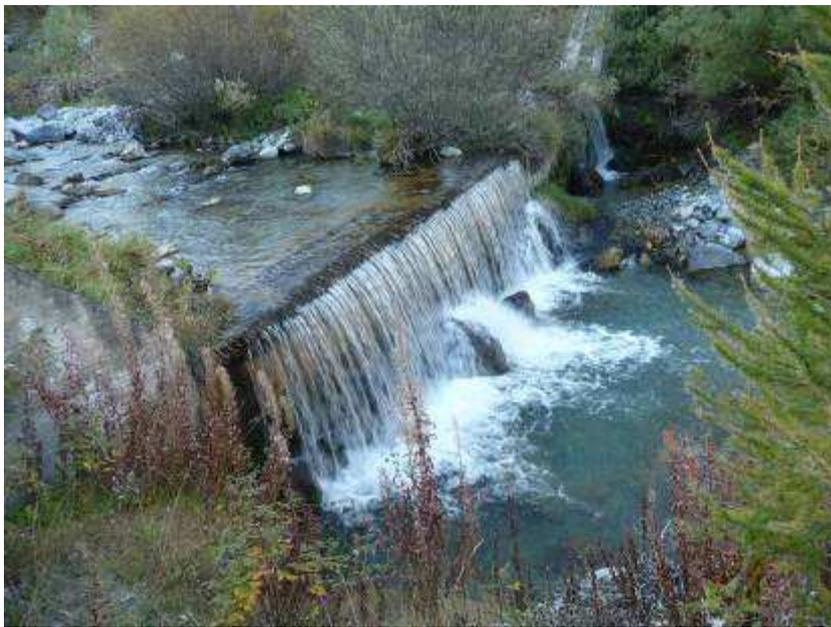
**Figura A3.11** Sezione non adatta alla chiusura a valle del modello: una briglia.
