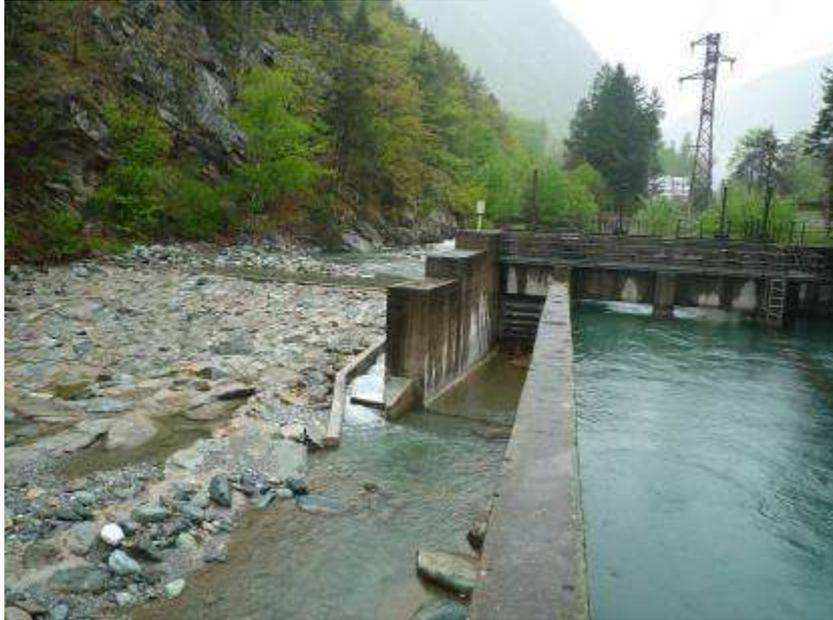
**Figura A3.7** Sezione di derivazione che può fungere da sezione di monte del modello: Derivazione e vasca di carico delle condotte che alimentano l'impianto di Roure, Val Chisone.
