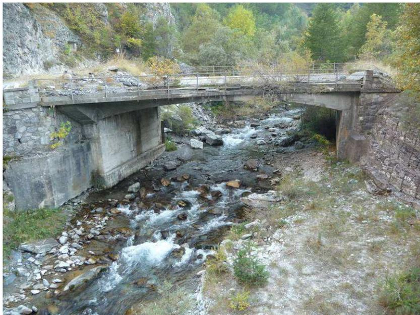
**Figura A3.13** Sezione non adatta alla chiusura a valle del modello: ponte senza pile in alveo, privo di fondazione continua a platea né in corrispondenza di un rivestimento inerosibile del fondo.
