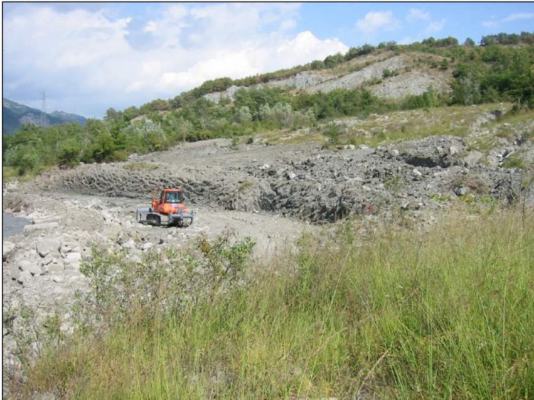
Figura 8b. Foto delle lavorazioni di modellamento della sponda del Torrente Limentra, “archivio Servizio Tecnico Area Bacino Reno, Regione Emilia-Romagna”, Località: Vimignano.
