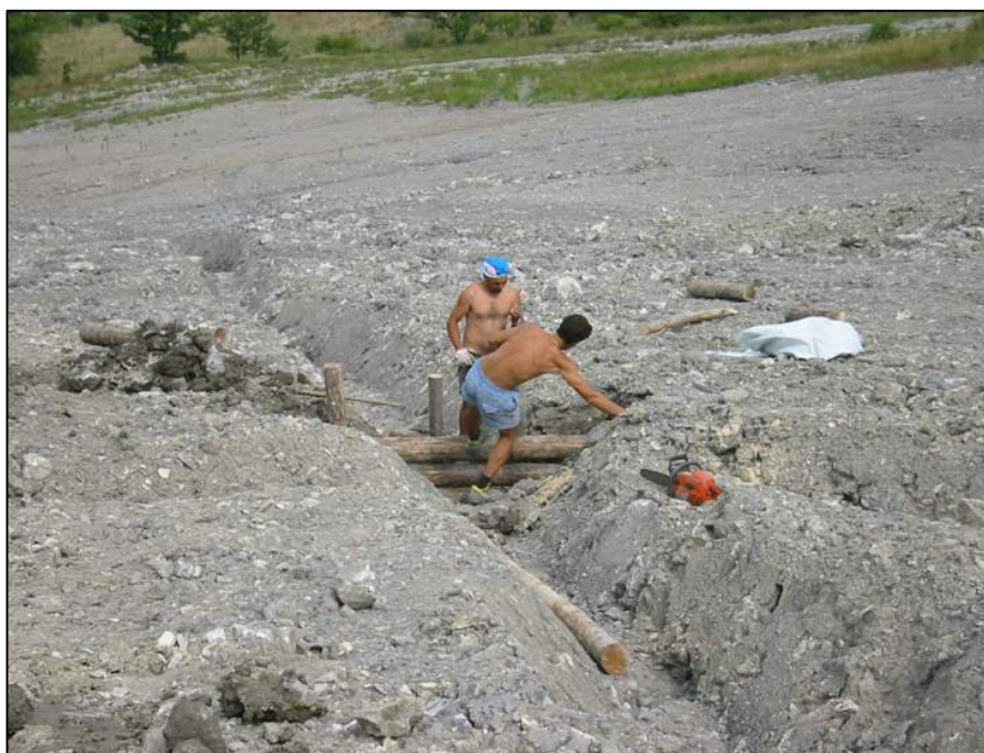
Figura 40. Costruzione/posa materiale legnoso costituente la briglia, “archivio Servizio Tecnico Area Bacino Reno, Regione Emilia-Romagna”.
