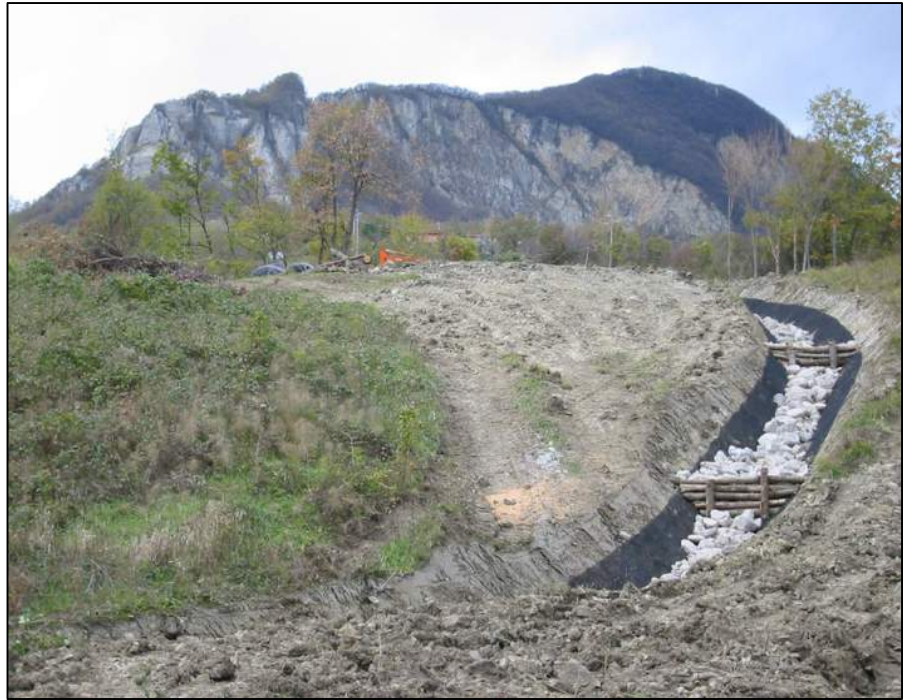
Figura 46. Evidente posa di pietrisco all'interno del fosso rivestito, "archivio Servizio Tecnico Area Bacino Reno, Regione Emilia-Romagna".
