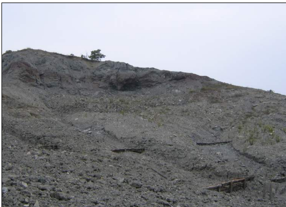
Figura 15. Briglie in legname realizzate all'interno dei fossi collettori, 2006, "archivio Servizio Tecnico Area Bacino Reno, Regione Emilia-Romagna", Località: Vimignano.
