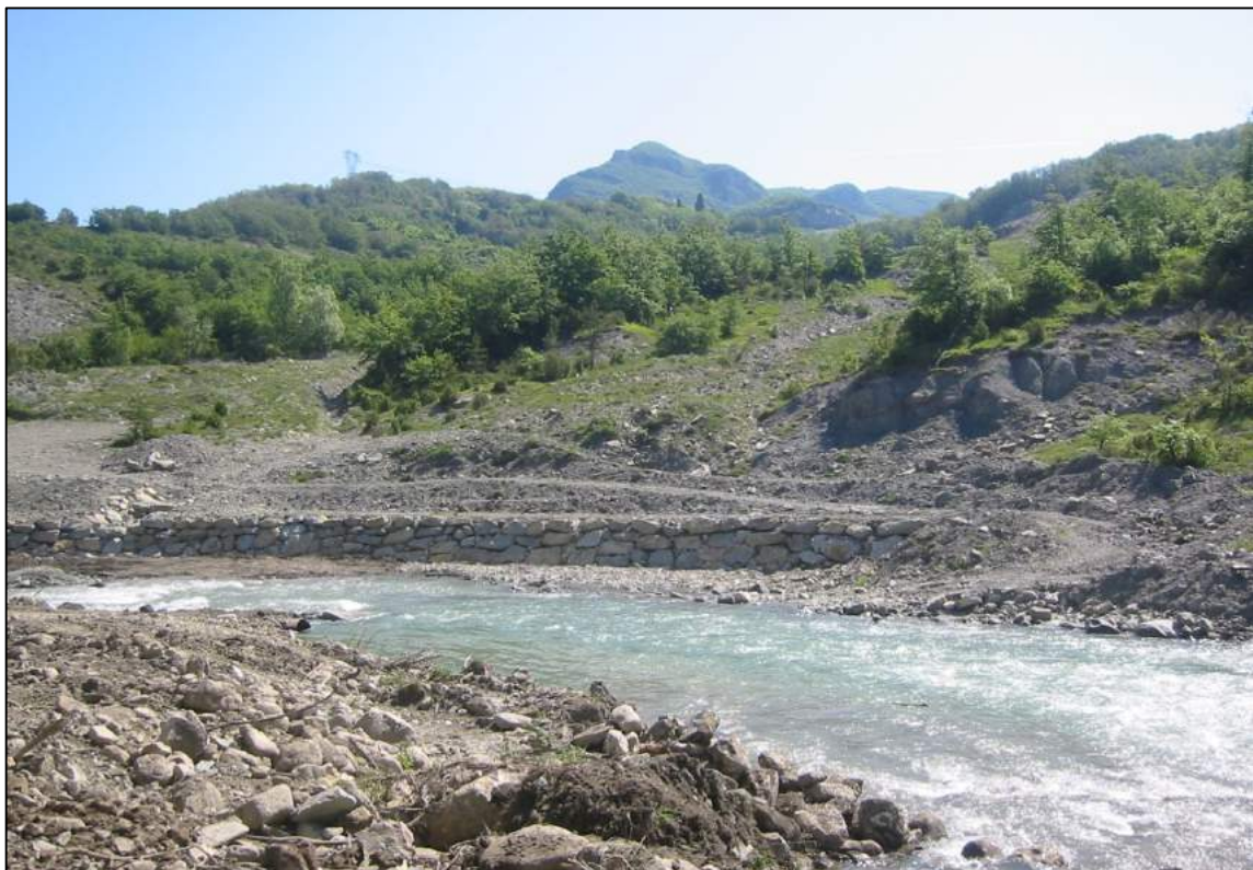
Figura 8c. Foto del risultato finale della scogliera in massi ciclopici, “archivio Servizio Tecnico Area Bacino Reno, Regione Emilia-Romagna”, Località: Vimignano.
