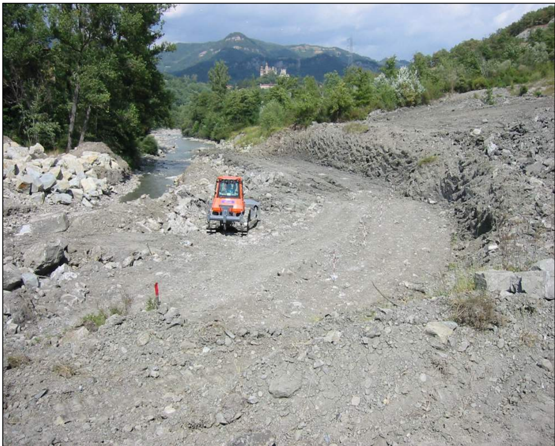
Figura 8a. Foto delle lavorazioni sulla sponda del Torrente Limetra con posa di massi ciclopici, "archivio Servizio Tecnico Area Bacino Reno, Regione Emilia-Romagna", Località: Vimignano.
