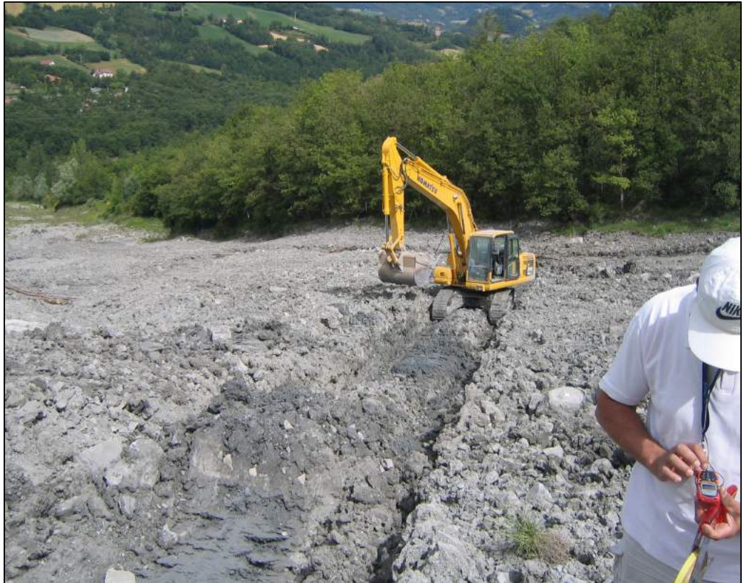
Figura 38. Esecuzione scavi per fossi collettori, “archivio Servizio Tecnico Area Bacino Reno, Regione Emilia-Romagna”, Località: Vimignano.
