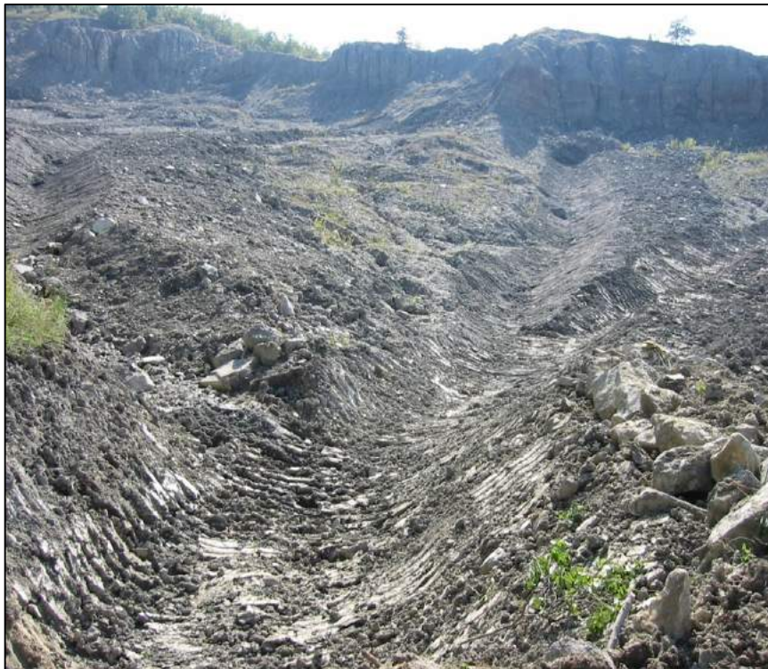
Figura 10b. Fosso realizzato nel 2006, “archivio Servizio Tecnico Area Bacino Reno”.
