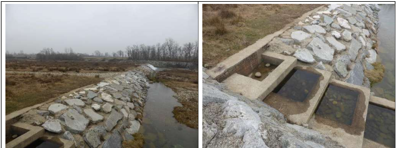
1° dislivello impercorribile e dettaglio del "passaggio per pesci"
