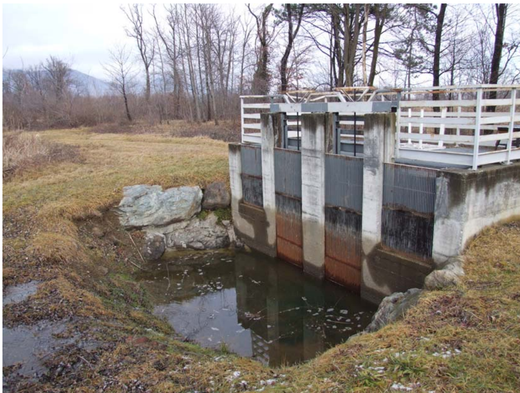
Figura 25 – Particolari della paratoia del sistema scolmatore.
