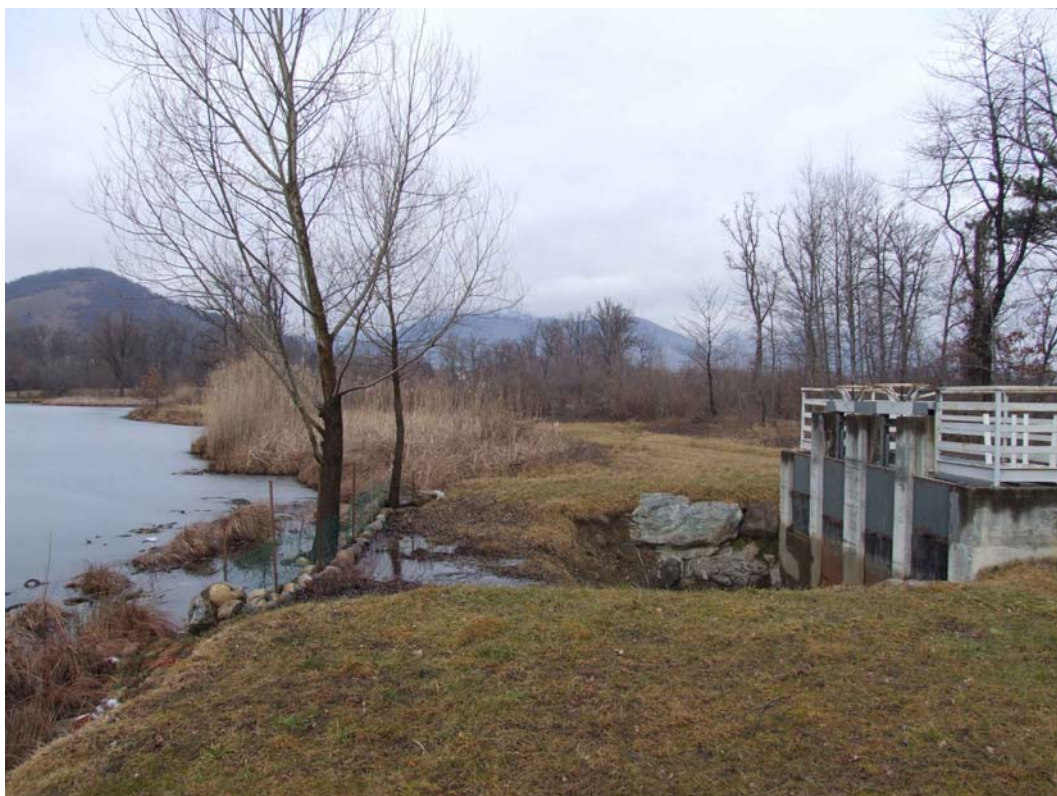
Figura 23 – Sistema scolmatore posto al fondo del Lago Inferiore di Caselette realizzato qualche anno addietro e che risulta piuttosto negativo limitando il livello idrico del lago e conseguentemente l’ampiezza delle cenosi palustri di margine. Come si può osservare il livello idrico può subire limitate fluttuazioni oltre le quali i maggiori livelli tracimano nello stesso sistema scolmatore.
