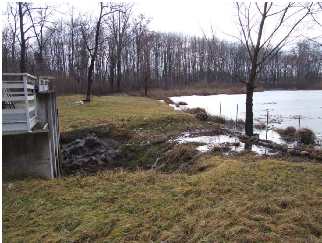
Figura 98 – Sistema scolmatore su cui è necessario intervenire.
