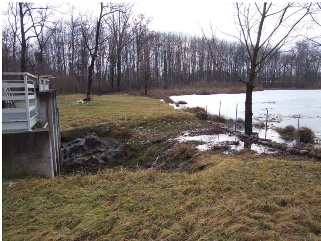
Figura 24 – Particolare ravvicinato del sistema scolmatore nel suo complesso.
