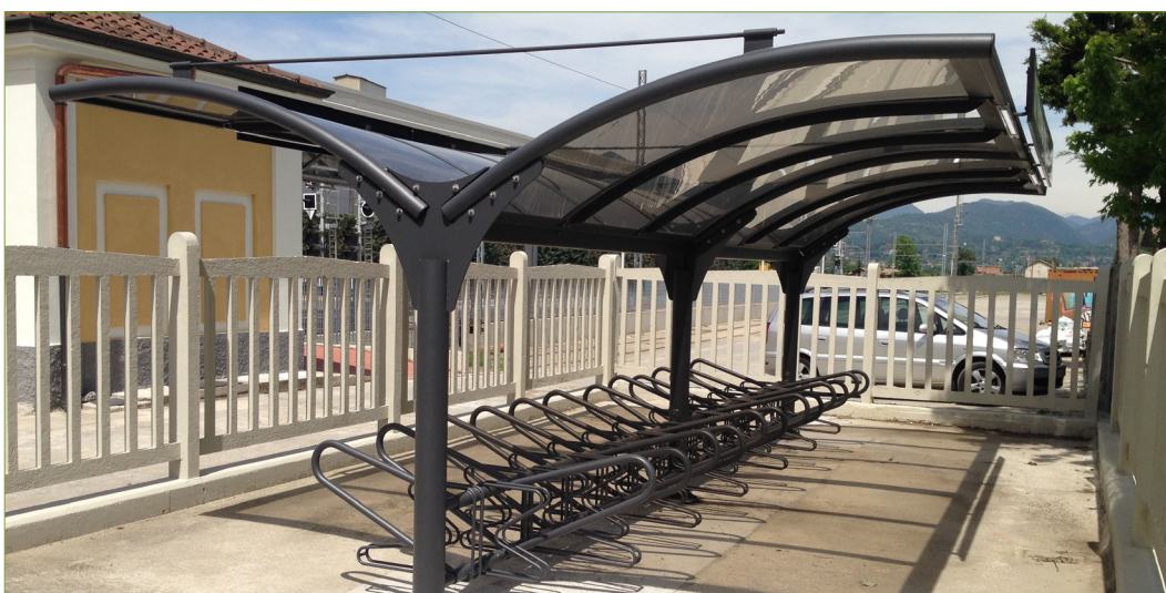
Tettoia a pensilina aperta sui lati
