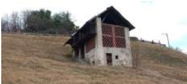
Edificio rurale ad Artò
