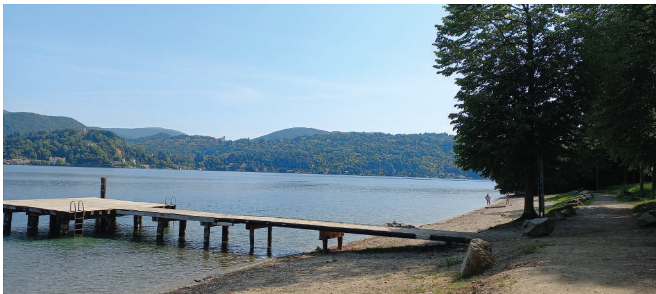
Spiaggia pubblica attrezzata in Frazione Lagna dove è prevista la realizzazione di un edificio a servizi per la fruizione turistica
