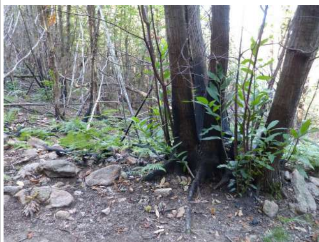
Figura 8: Scalzamento apparati radicali
