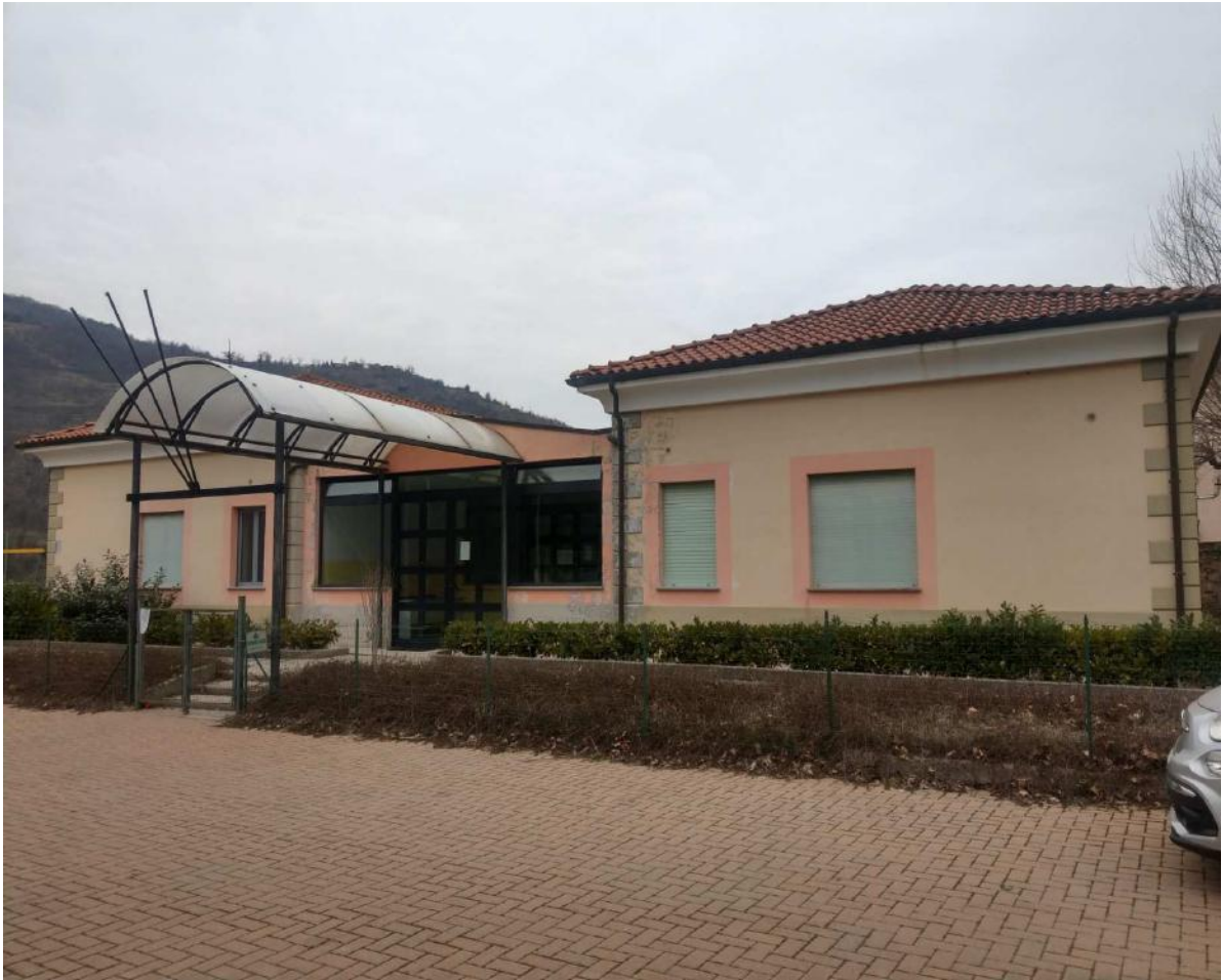
La struttura scolastica oggetto d'intervento a Monesiglio
