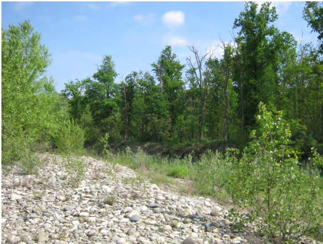
FOTO 10 – Vista da valle verso monte deposito centrale e incisione in sponda sinistra canale Sud
