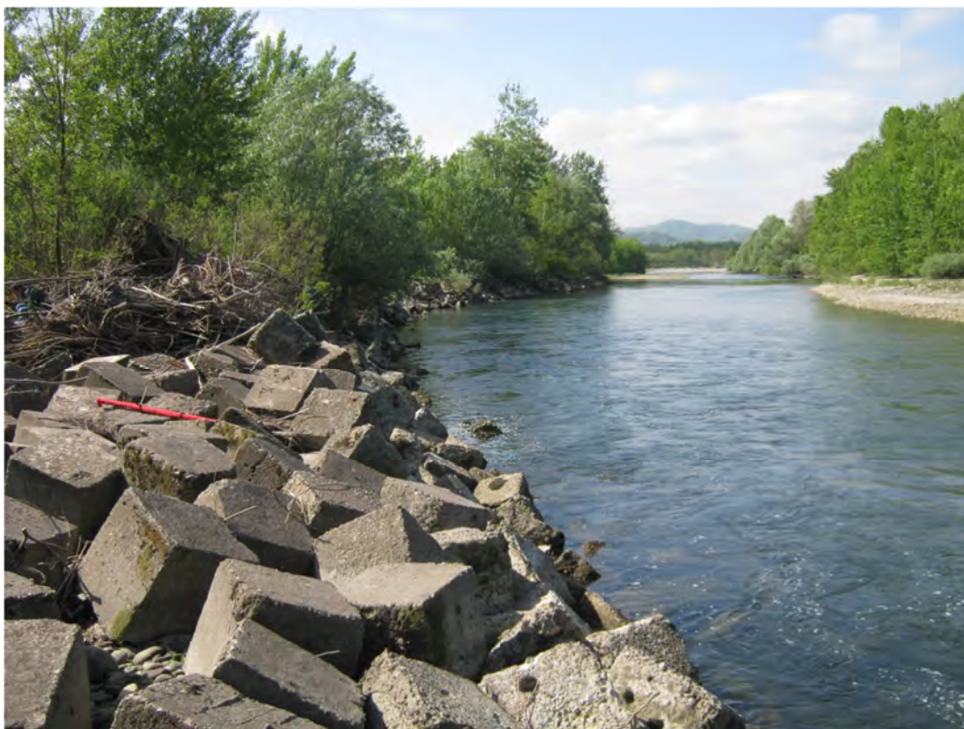
FOTO 19 – Vista verso valle del fiume Dora Baltea e dell'opera in prismi di calcestruzzo all'imbocco del canale Sud
