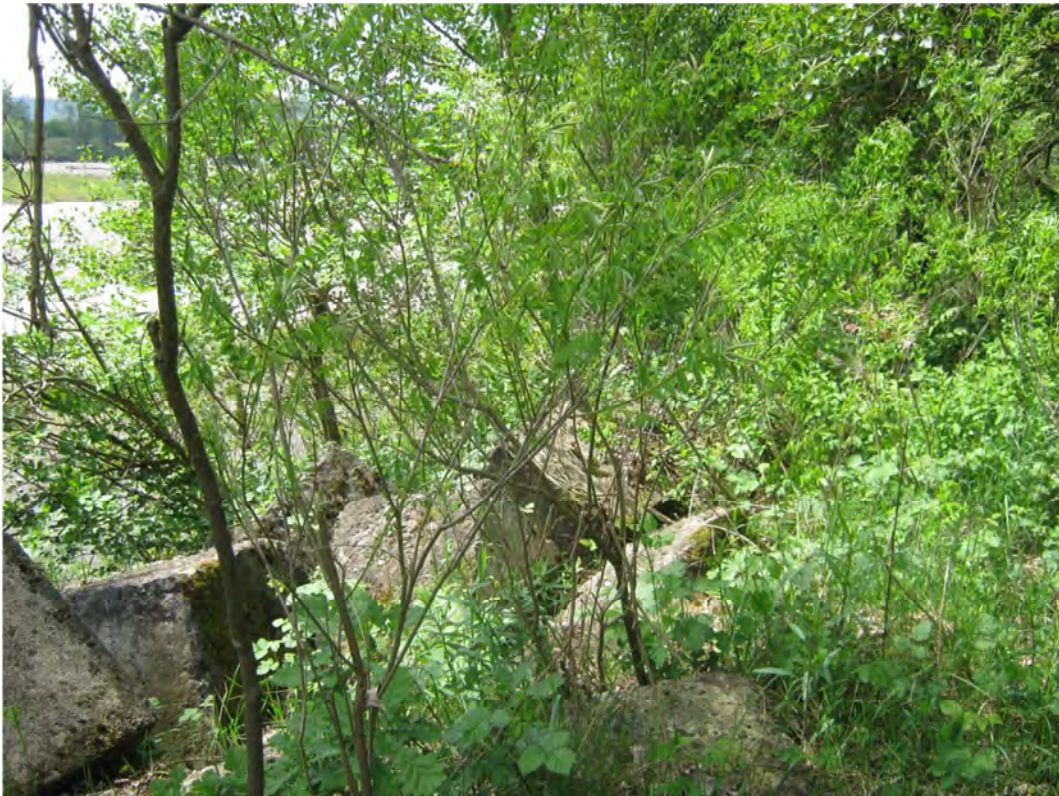
FOTO 24 – Vista opera di difesa in prismi esistente dove previsto lo sbocco del canale Nord
