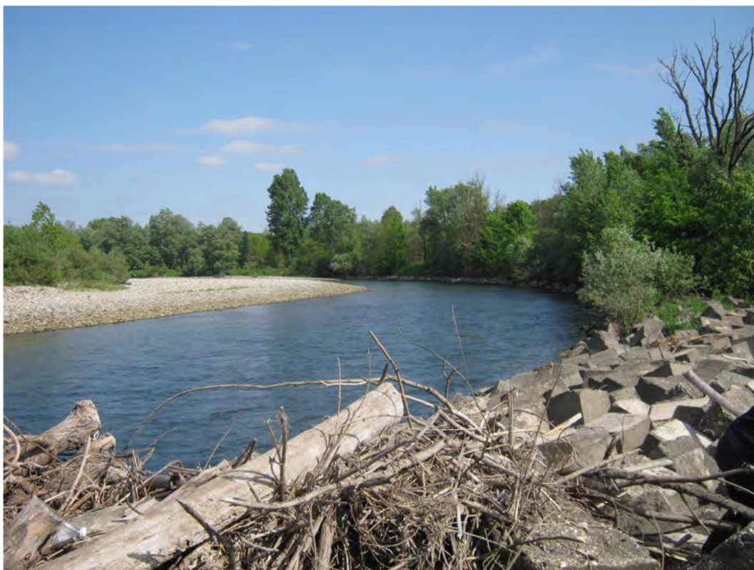
FOTO 17 – Vista verso monte del fiume Dora Baltea e dell'opera in prismi di calcestruzzo all'imbocco dei canali
