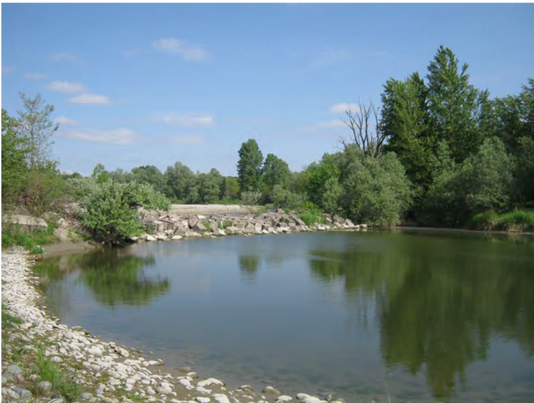
FOTO 14 – Vista da valle verso monte opera in prismi di calcestruzzo all’imbocco dei canali
