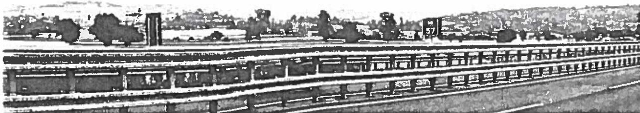
RILIEVO FOTOGRAFICO DALL'AUTOSTRADA (1)
