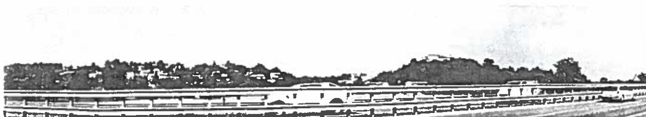
RILIEVO FOTOGRAFICO DALL'AUTOSTRADA (2)
