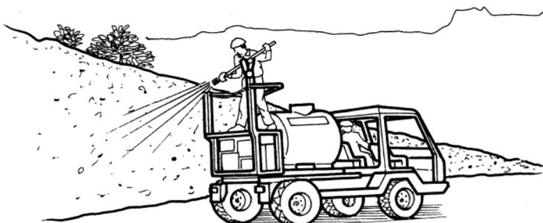
**Figura 37 - Inerbimento delle scarpate con idroseminatrice su autocarro<sup>7</sup>**
