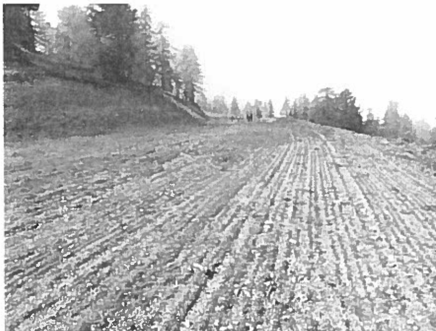
Foto 12: Zona E - allargamento e regolarizzazione della pista
