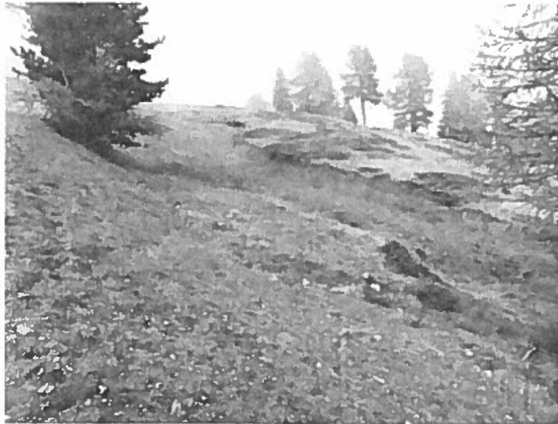
Foto 33: Zona F - dissesto superficiale
