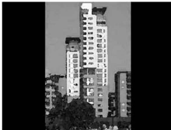
Intervento di Edilizia Residenziale Pubblica finanziato in Torino
