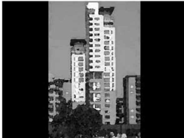
Intervento di Edilizia Residenziale Pubblica finanziato in Torino
