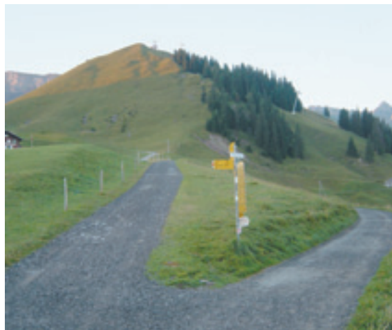
Figura 2.3 - Strada trattorabile di servizio a insediamenti agricoli in quota, utilizzata in modo intensivo per il turismo estivo (Klewenalp, Lago dei quattro Cantoni - CH).
