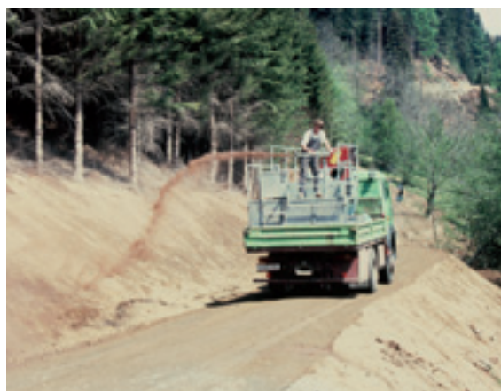
Figura 4.6 - Scarpate troppo ripide sono l'origine di fenomeni di erosione e franamento anche in terreni per natura stabili (sx Valli di Lanzo - To). Corretta sagomatura delle scarpate con rinverdimento mediante idrosemina (dx Salisburghese -Austria).
