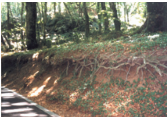
Figura 2.7 - Il reticolo di radici di faggio forma una struttura di protezione dall'erosione della scarpata stradale (M.ti Cimini-Vt).
