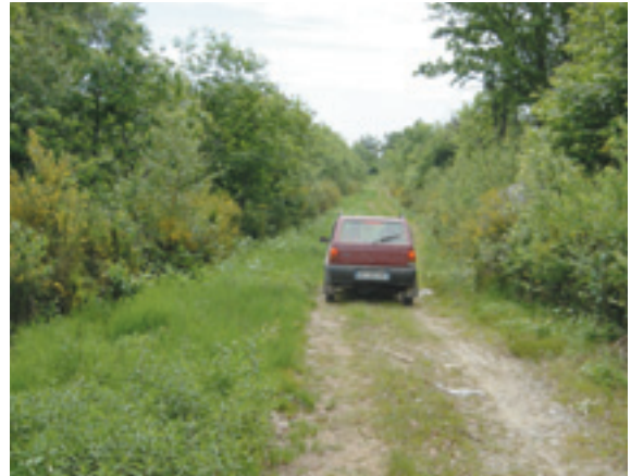
Figura 4.8 - Pista camionabile: la larghezza della piattaforma stradale è di 4,5 m; non vi è distinzione fra piano viabile e banchine (anch'esse transitabili) se non per il ripetuto passaggio dei mezzi che ha costipato e reso meno ospitale per la vegetazione erbacea l'area percorsa dalle ruote dei mezzi (Serra d'Ivrea – Bi)
