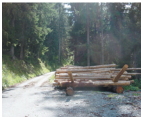
Figura 6.21 - Piazzale di deposito lungo una strada trattorabile. Il legname da lavoro richiede una larghezza del piazzale di almeno 5 m oltre alla normale sezione stradale (Kippel, Löttschental – CH).
