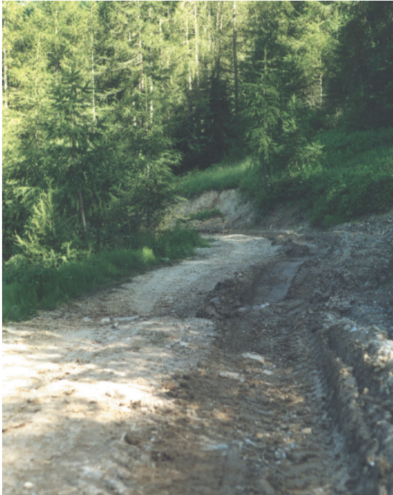
Figura 7.7 - Danni per il passaggio dei mezzi di esbosco su una pista trattorabile. Tali danni sono in parte contenibili vietando la circolazione dei trattori nei giorni successivi a precipitazioni atmosferiche. Se le attività di esbosco hanno una certa rilevanza e continuità occorre prevedere i costi di ripristino della pista al termine delle utilizzazioni (Acceglio – Cn).
