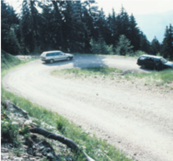
Figura 4.7 - Strada camionabile secondaria: i tornanti hanno ampio raggio di curvatura (Salisburghe- se -Austria).
