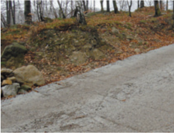
Figura 4.4 - Per brevi tratti ripidi (pendenza superiore al 15-18%) è possibile adottare, anche per le piste, un rivestimento in calcestruzzo di cemento al fine di evitare fenomeni erosivi del fondo viabile (Mottarone-Vb).
