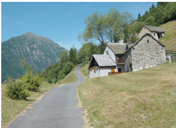
Figura 7.3 - In alcune aree alpine la viabilità silvo-pastorale serve anche per la fruizione di case per le vacanze realizzate mediante il recupero di vecchi edifici rurali. Per tale utilizzo, che può assumere anche un'importanza economica prevalente rispetto alla stessa gestione silvo-pastorale, occorre ancora trovare adeguate forme di regolamentazione, a tutela di una corretta fruizione del territorio e a garanzia della sicurezza del traffico veicolare (Valle del Sempione - Vb).
