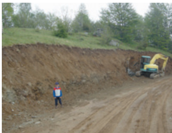
Figura 4.6 - Scarpate troppo ripide sono l'origine di fenomeni di erosione e franamento anche in terreni per natura stabili (sx Valli di Lanzo - To). Corretta sagomatura delle scarpate con rinverdimento mediante idrosemina (dx Salisburghese -Austria).
