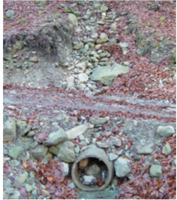
Figura 2.4 - Problemi legati alla regimazione delle acque lungo la viabilità agro-silvopastorale: a sx sgrondo di acque affioranti dalla scarpata di monte; a dx occlusione di tomboni in conseguenza del forte trasporto solido delle acque superficiali. Entrambe i casi possono essere risolti realizzando adeguate opere d'arte (Valli di Lanzo-To).
