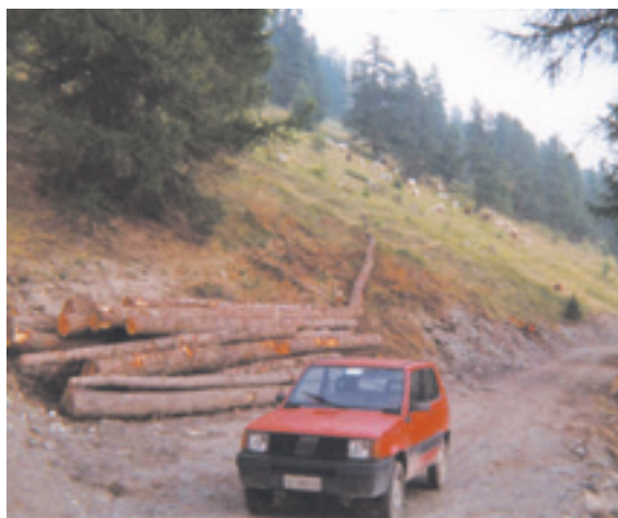
Figura 2.2 - Pista silvo-pastorale in zona montana dove si alternano pascoli privati e rimboschimenti di proprietà comunale (Valle Maira-Cn).
