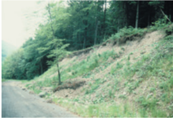
Figura 2.5 - Instabilità delle scarpate per fenomeni erosivi diffusi collegabili ad un mancato o non corretto consolidamento delle superfici di scavo (a sx strada camionabile nella provincia di Brno-Slovacchia; a dx pista trattorabile sul Mottarone - Vb).
