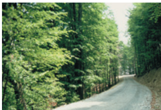
Figura 4.3 - Strada camionabile in corso di realizzazione; la massiccata è costituita da strato di ghiaia di differente granulometria (più fine nell'orizzonte superiore) (Brno-Slovacchia).
