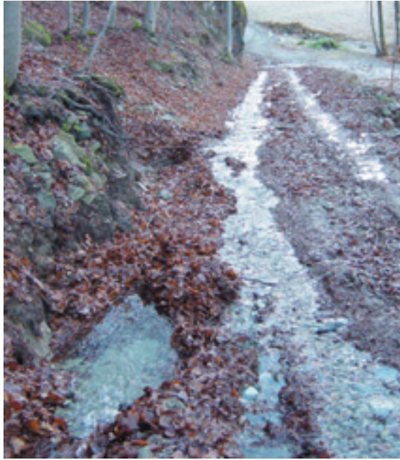
Figura 2.4 - Problemi legati alla regimazione delle acque lungo la viabilità agro-silvopastorale: a sx sgrondo di acque affioranti dalla scarpata di monte; a dx occlusione di tomboni in conseguenza del forte trasporto solido delle acque superficiali. Entrambe i casi possono essere risolti realizzando adeguate opere d'arte (Valli di Lanzo-To).
