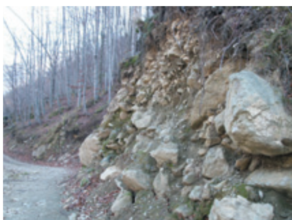
Figura 6.14 - Dalla natura dei terreni in scavo dipende la stabilità delle scarpate, la portanza del corpo stradale e la possibilità di movimentare il materiale di scavo nel cantiere (Aia di Stura - To).
