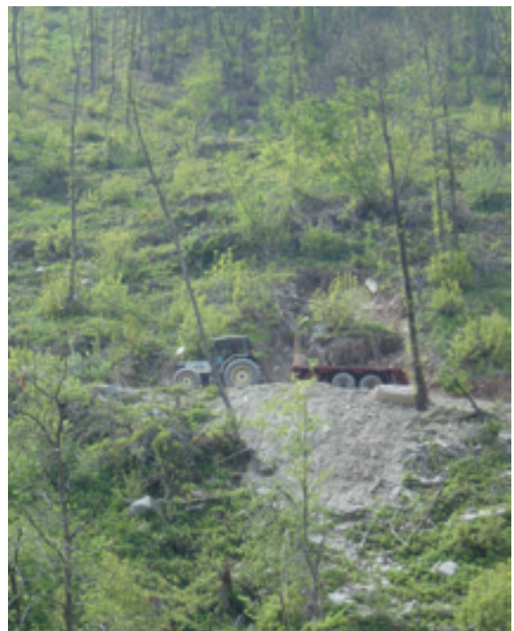
Figura 2.6 - Scarico non controllato di materiali inerti a valle di una pista aperta per la ceduzione di un castagneto in Val Casotto (Cn).
