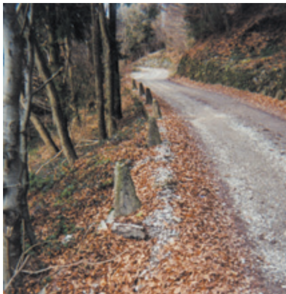
Figura 3.4 - Strada trattorabile con funzioni agro-silvopastorali e di servizio a seconde case, il cui corredo di opere d'arte (muri di sostegno e paracarri in pietra) indica che in passato assicurava il collegamento di centri abitati e insediamenti produttivi (miniere) di una certa importanza (Dossena – Bg).
