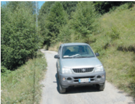
Figura 4.9 - Strada trattorabile: la larghezza della piattaforma, di 2,5 m, è occupata interamente dal piano viabile (banchine assenti). La presenza di un fondo migliorato e drenante permette il passaggio di autoveicoli a due ruote motrici anche dopo lunghi piogge (Valle Ossola – Vb).
