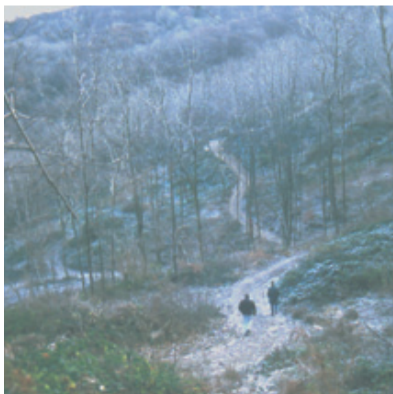
Figura 5.6 - Nel tracciamento si deve cercare di adattare il percorso della pista alla morfologia del versante (Luino - Va).
