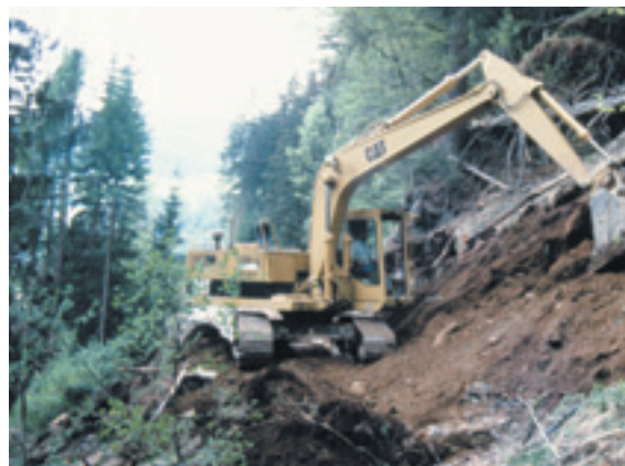
Figura 6.16 - Apertura del tracciato con escavatore.
