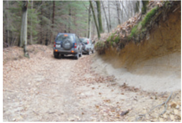
Figura 2.5 - Instabilità delle scarpate per fenomeni erosivi diffusi collegabili ad un mancato o non corretto consolidamento delle superfici di scavo (a sx strada camionabile nella provincia di Brno-Slovacchia; a dx pista trattorabile sul Mottarone - Vb).
