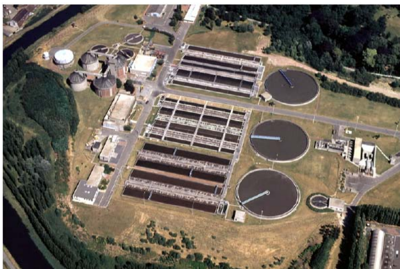
Figura 35 - Impianto di depurazione Marquette
