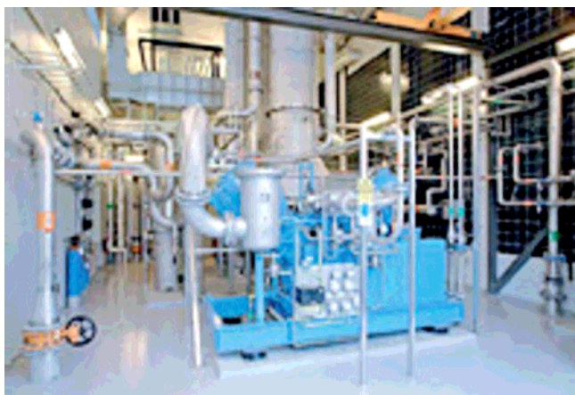
Figura 30 – Impianto di lavaggio ad acqua pressurizzata a Stoccolma [Malmberg (2008)]
