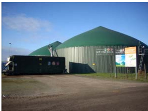
Figura 38 – I reattori anaerobici per la produzione di biogas dell'impianto di Godenstedt.
