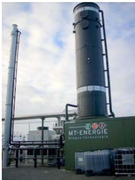
Figura 37 – Impianto di upgrading a Godenstedt
