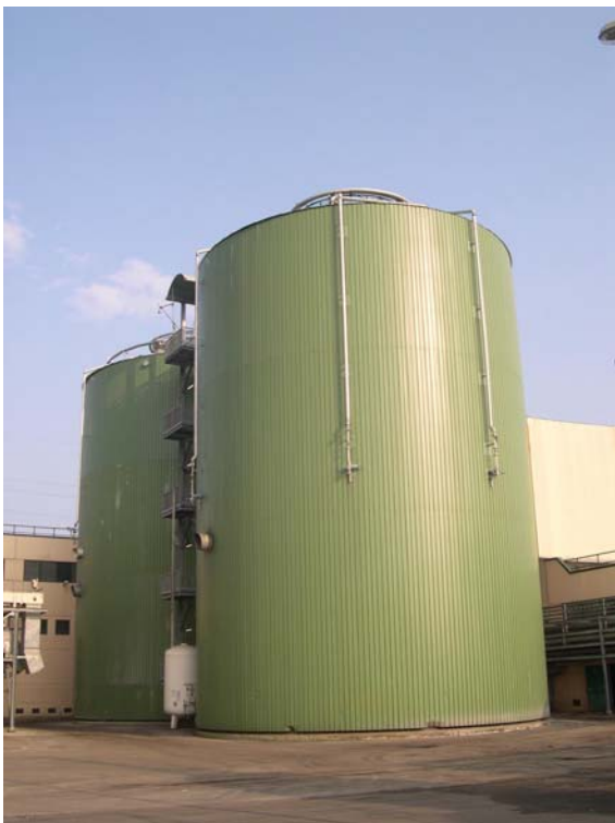
Figura 44 - Digestori anaerobici della linea FORSU di ACEA Pinerolese
