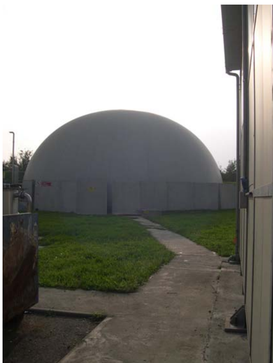
Figura 48 - Gasometro per lo stoccaggio del biogas prodotto
