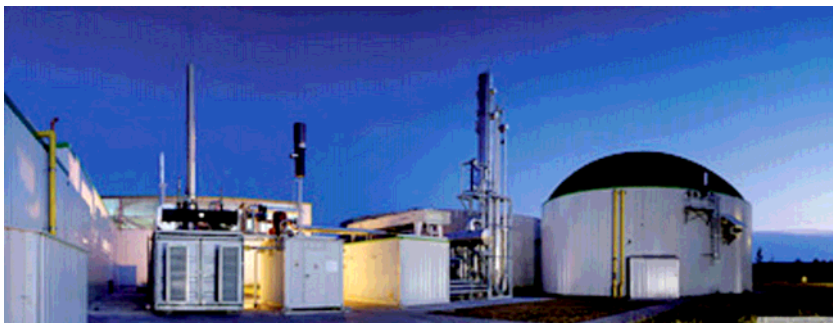
Figura 28 - Impianto pilota MEA a Schwandorf (Schmack Biogas AG)
