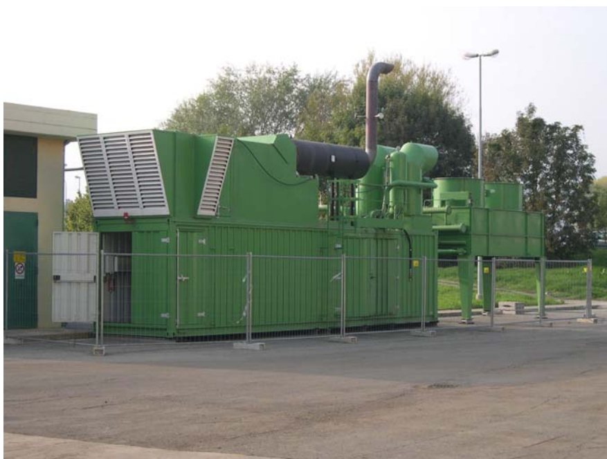
Figura 46 - Cogeneratore per l'utilizzazione del biogas prodotto
