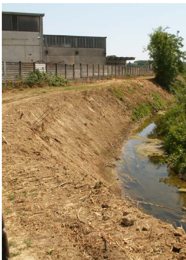
Tratto Rotaldo in adiacenza all'area industriale di Occiminano a monte del ponte di attraversamento della ex S.S. 31
