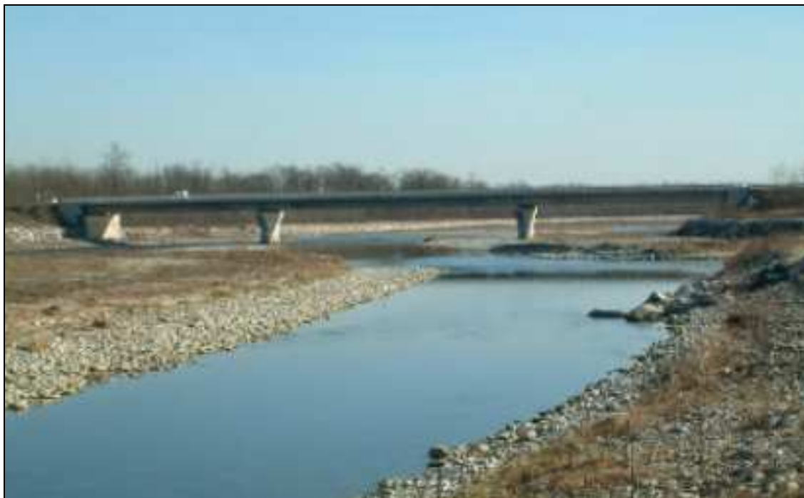
Fig. 12 Ponte della SP 40 San Benigno Canavese - Foglizzo
