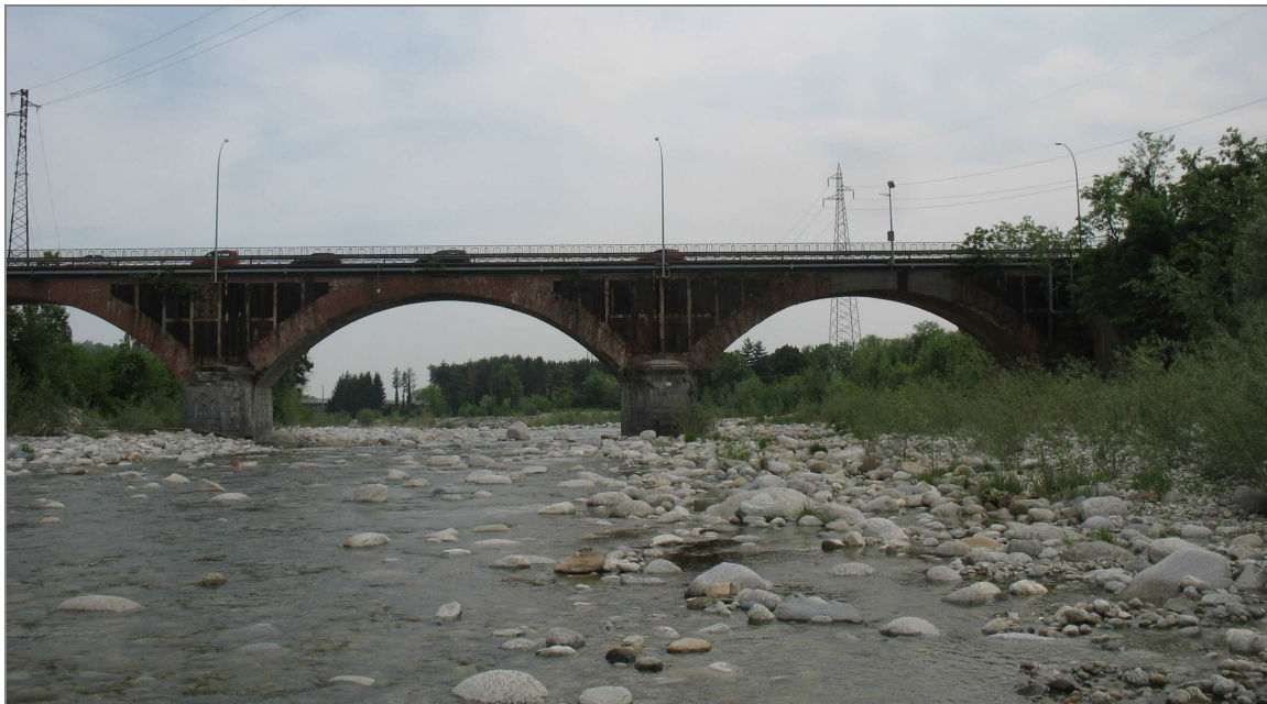
Fig. 18 Ponte a Cuorgnè sulla ex SS 460 di Ceresole
