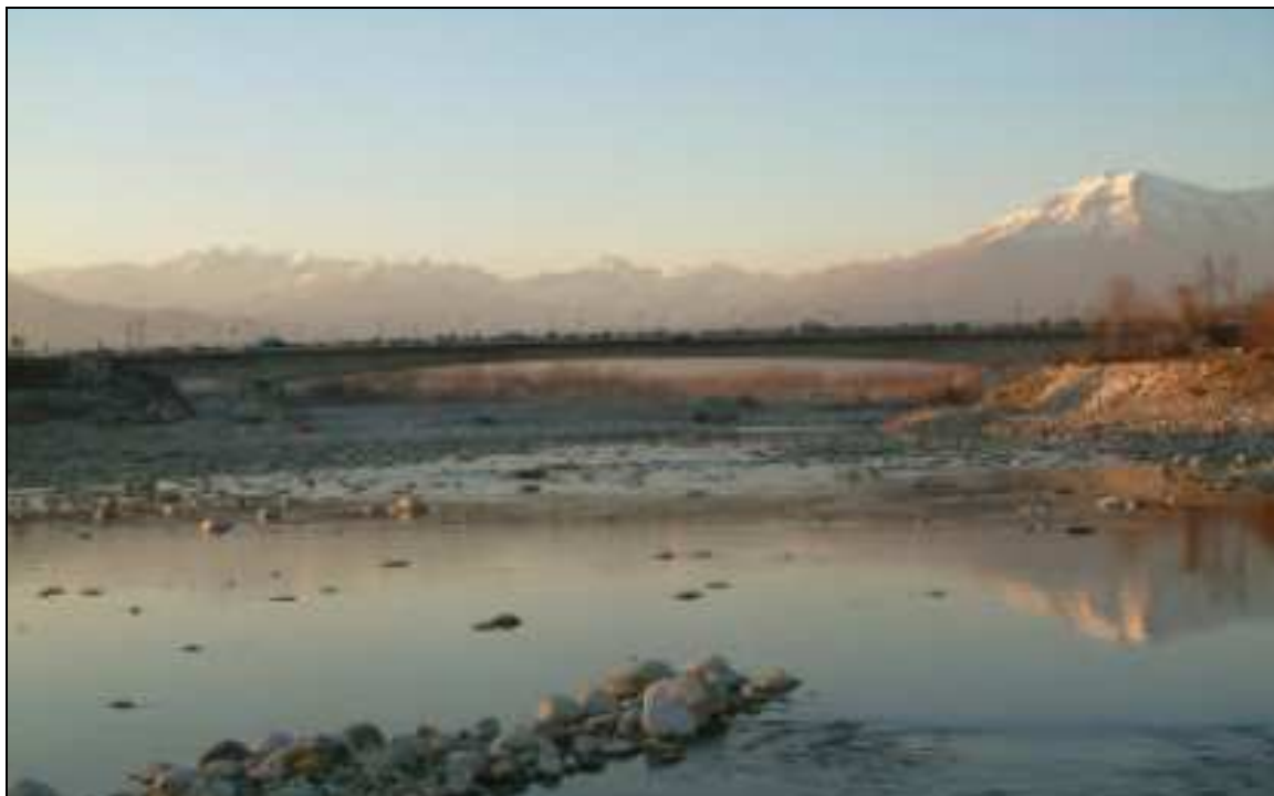
Fig. 14 Ponte della SP 222 di Castellamonte
