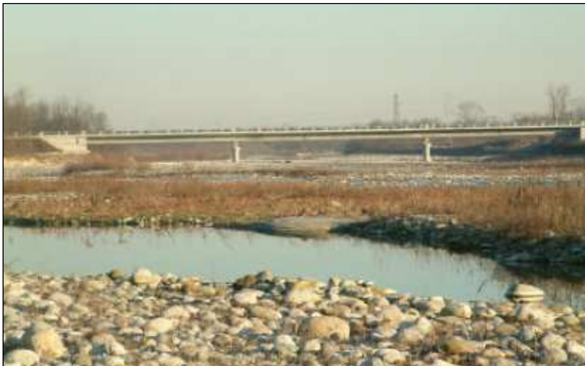
Fig. 13 Ponte della SP 41 Feletto - Agliè
