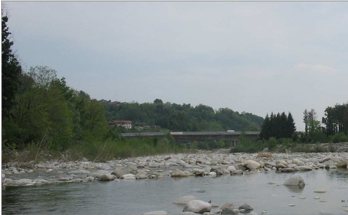
Fig. 17 Ponte circonvallazione di Cuorgnè di collegamento della ex SS 460 con la SP 58
