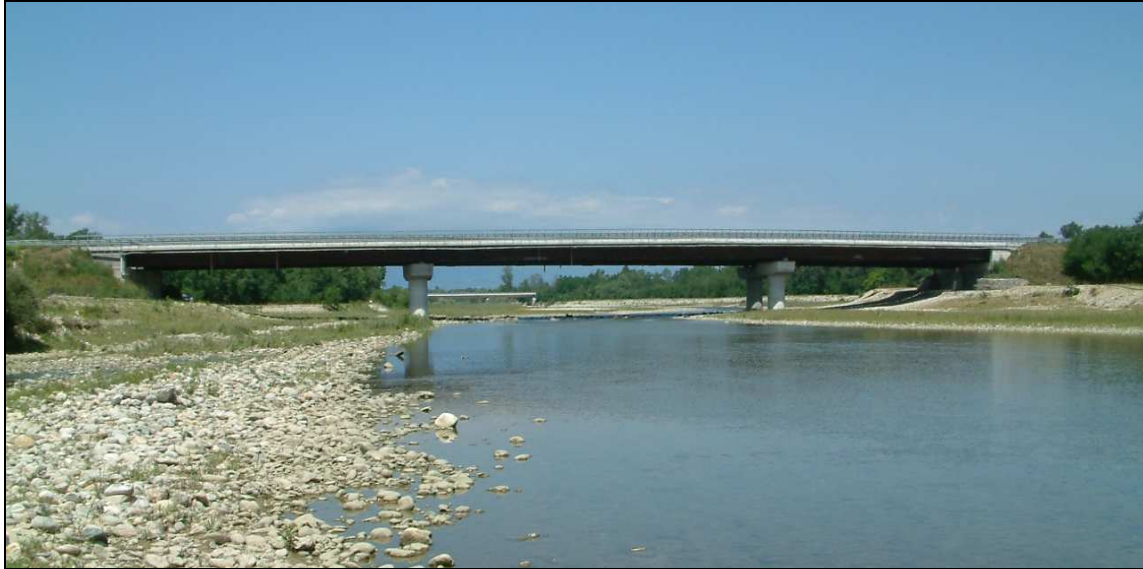
Fig. 11 Ponte dell'autostrada A5 To-Ao
