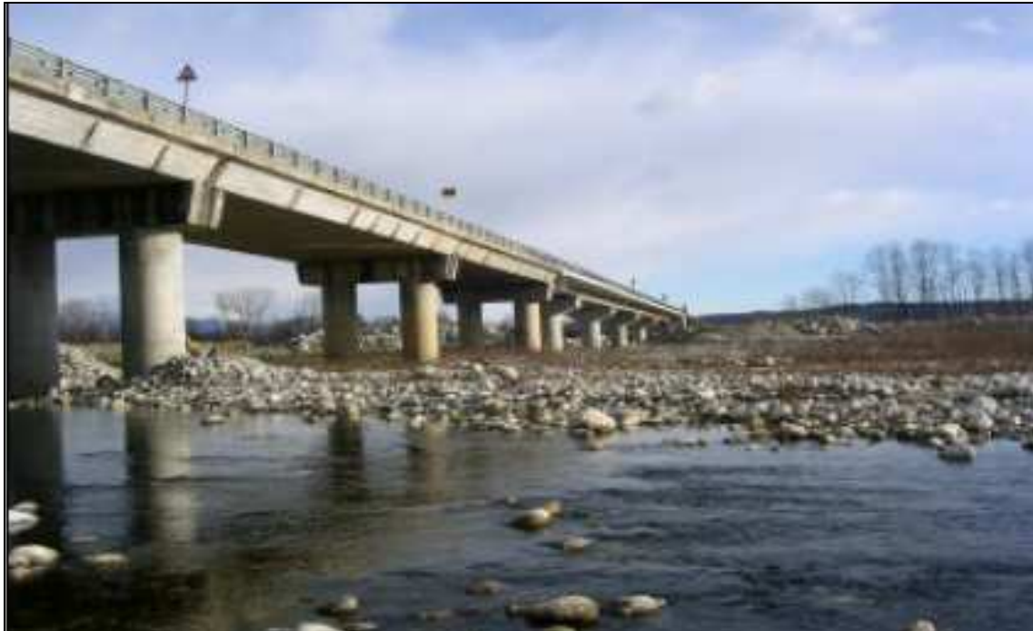
Fig. 15 Ponte della SS 565 tra Salassa e Castellamonte
