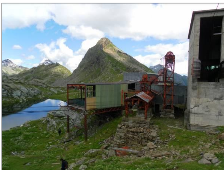
Figure 4.1.5/3 - Attuale stazione di arrivo a Bocchetta delle Pisse dell'impianto cestovia della Balma
