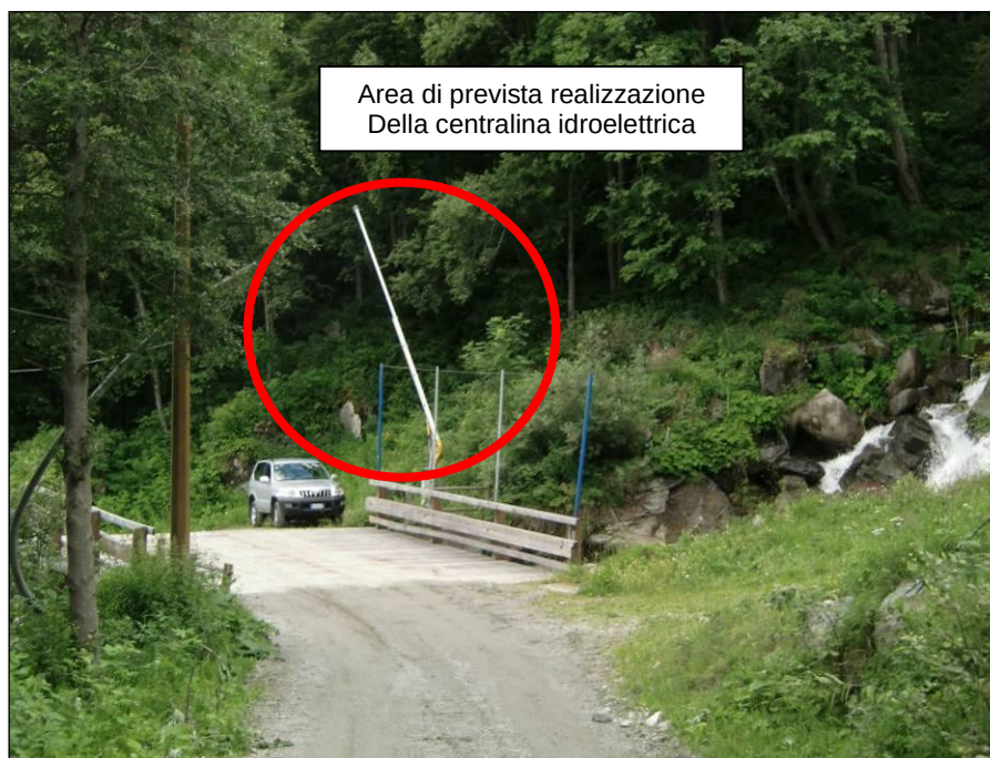
Figura 4.1.3/2 - Vista del punto di localizzazione della centralina idroelettrica
