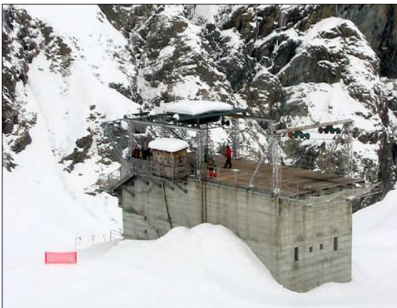
Figura 4.1.5/2 - Attuale stazione di partenza dell'impianto della Balma (cestovia dismessa)
