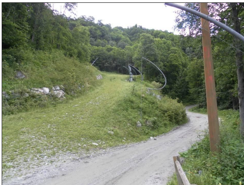
Figura 4.1.7/2 - Area di previsto allargamento della pista Pianalunga – Alagna, nella foto riportata, il muro di contenimento e il relativo allargamento della pista avranno luogo a destra della pista esistente
