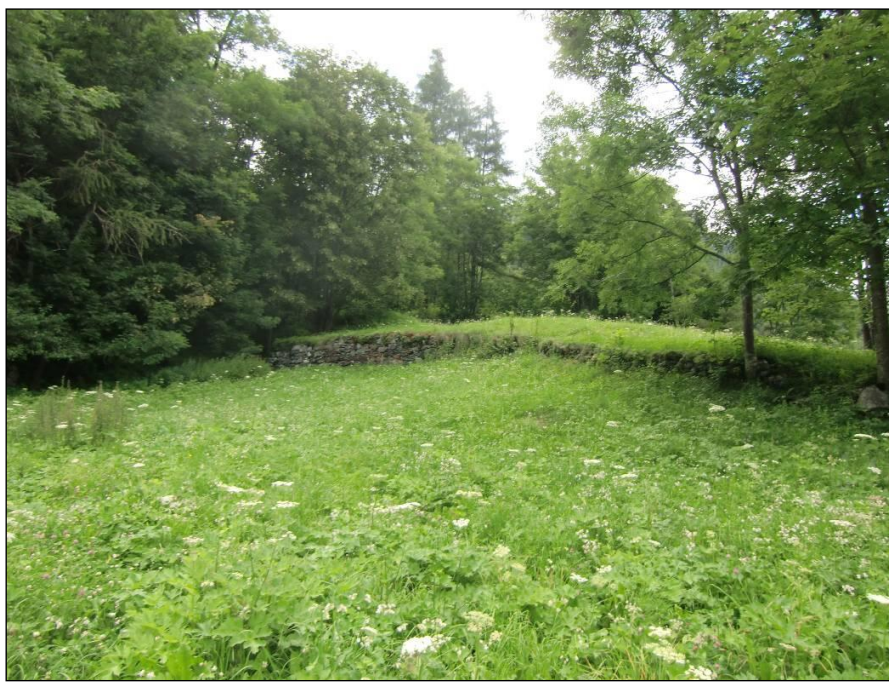
Figura 4.1.12/5 - Muretto a secco di prevista demolizione in corrispondenza del tratto intermedio della variante
