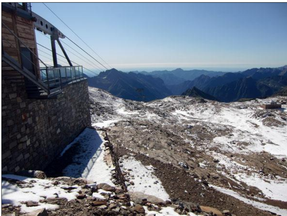
Figura 4.1.6/4 il corridoio d'intervento visto dalla stazione di monte dell'impianto esistente
