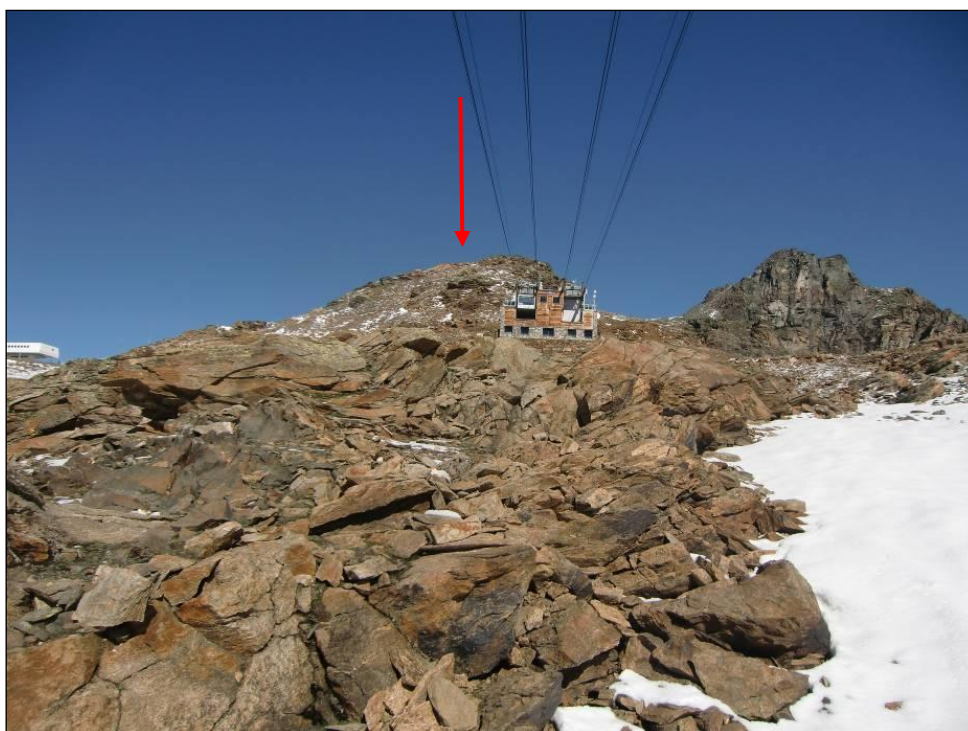
Figura 4.1.6/5 la stazione di monte della funivia esistente vista da valle, nello sfondo sono visibili le prime pendici di cima Stolemborg in corrispondenza delle quali, in posizione arretrata, sarà realizzata la stazione di monte dell'impianto in progetto
