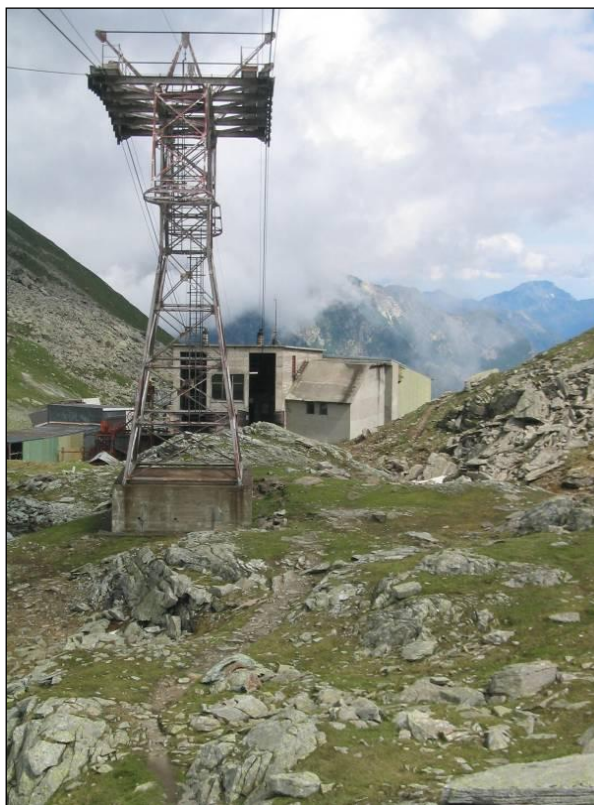
Figura 4.1.14/4 Funivia di Punta Indren – Sostegno Stazione
