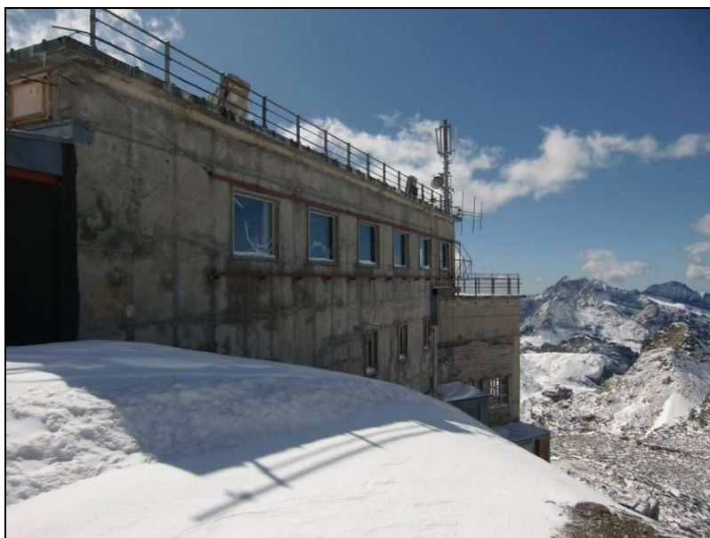
Figura 4.9/7 – Funivia di Punta Indren - La stazione di monte
