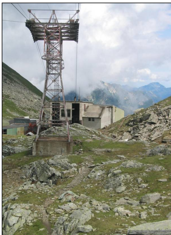
Figura 4.9/6 Funivia di Punta Indren – Il sostegno n. 1, Stazione, di prevista demolizione, e sullo sfondo la stazione di valle
