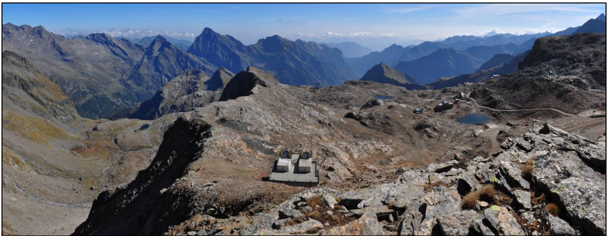
Figura 4.9/1 Passo dei Salati con la stazione di arrivo dell'impianto Funifor. Sulla sinistra il vallone di Bors, sulla destra i laghetti nei pressi dell'Istituto Mosso
