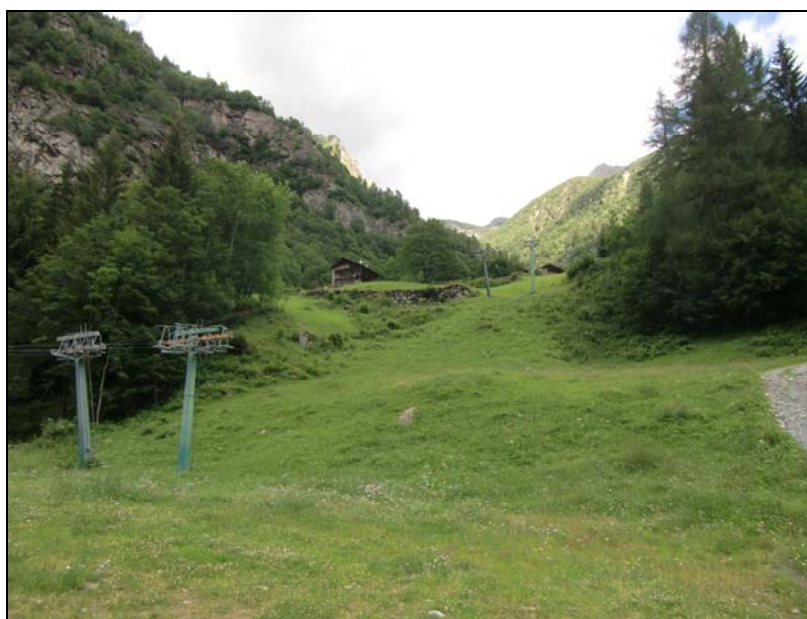
Figura 4.9/8 Impianti Wold - Attuali impianti di risalita
