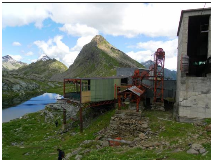
Figure 4.9/5 Attuale stazione di arrivo a Bocchetta delle Pisse dell'impianto Balma
